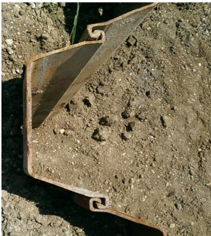
Slika 44. Način spajanja žmurja
