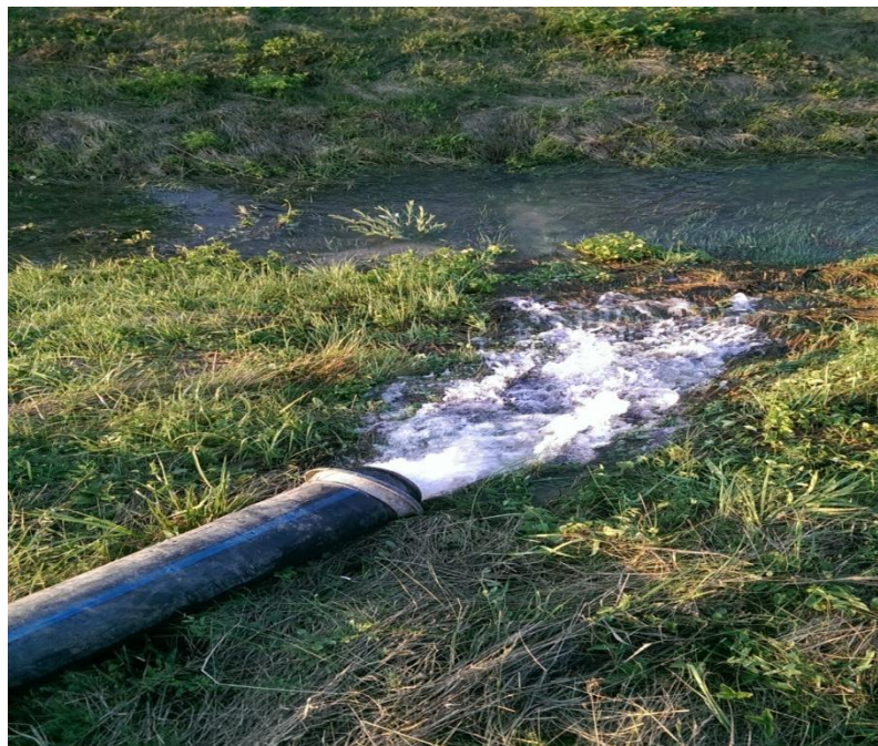
Slika 51. Odvođenje vode u odvodni kanal
