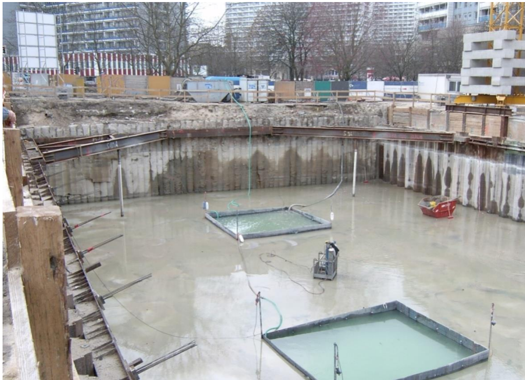
Slika 13. Voda u građevinskoj jami
