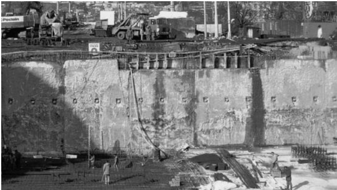
Slika 10. Armiranobetonska dijafragma
