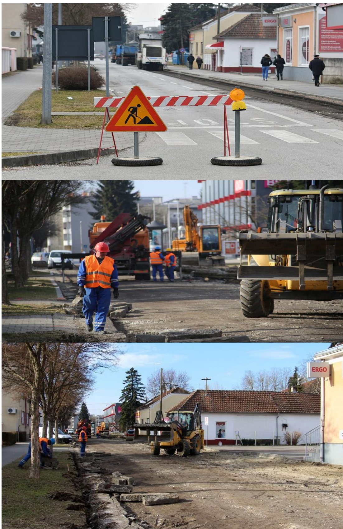
Slika br.10 : Radovi u tijeku (vlastiti izvor)
