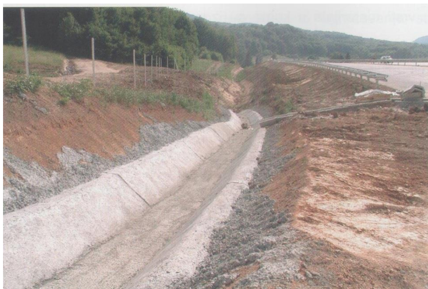
Slika 2. Trapezni odvodni jarak
