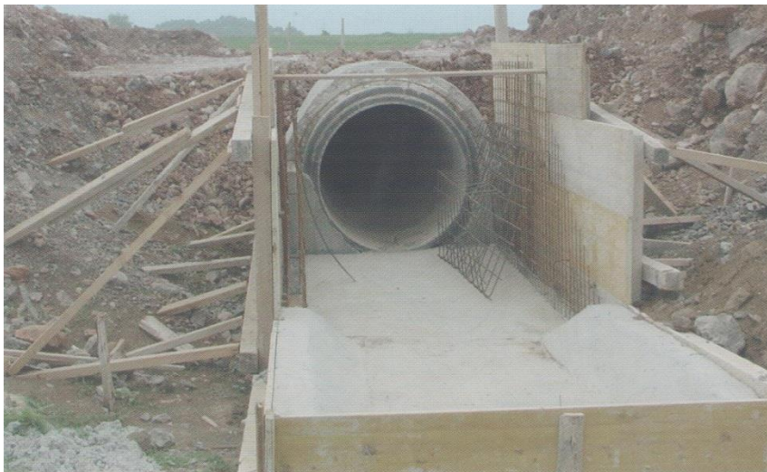
Slika 13. Cijevni propusti
