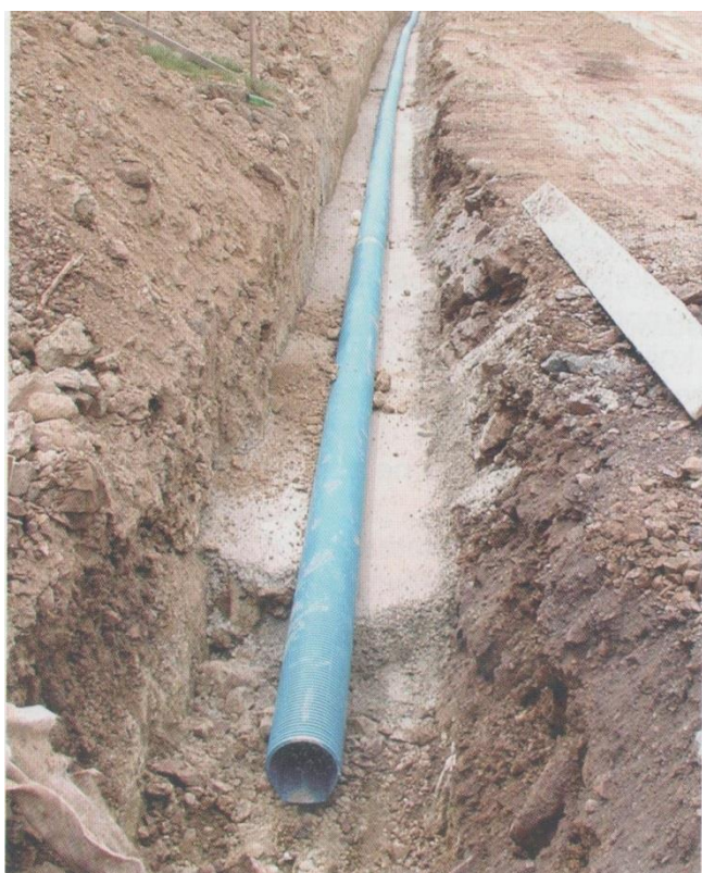
Slika 11. Plastična drenažna cijev na podlozi od betona
