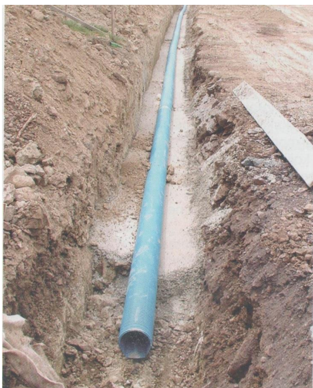
Slika 11. Plastična drenažna cijev na podlozi od betona
