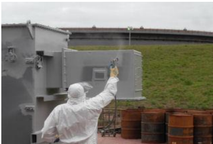
Slika 7. Nanošenje premaza bezračnim štrcanjem [6]
