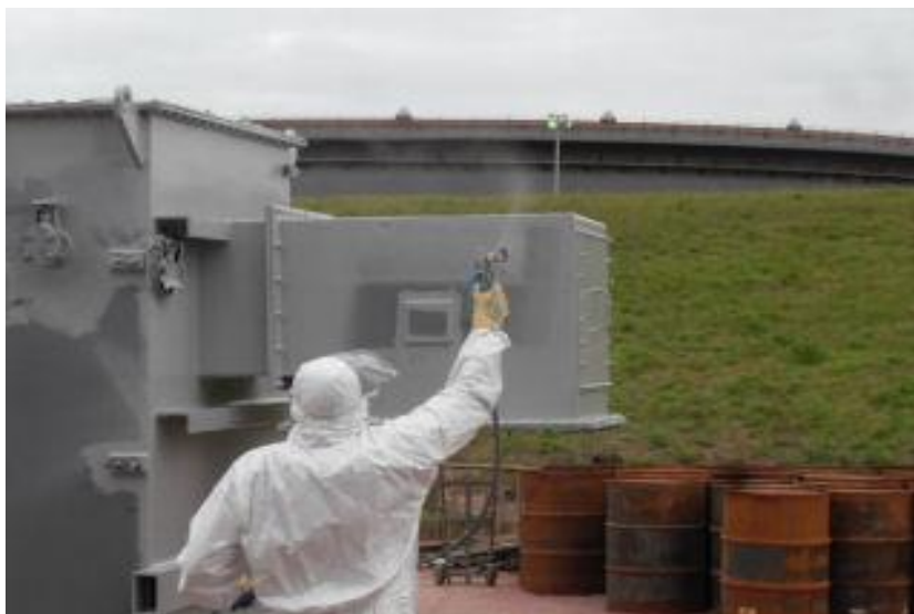
Slika 7. Nanošenje premaza bezračnim štrcanjem [6]
