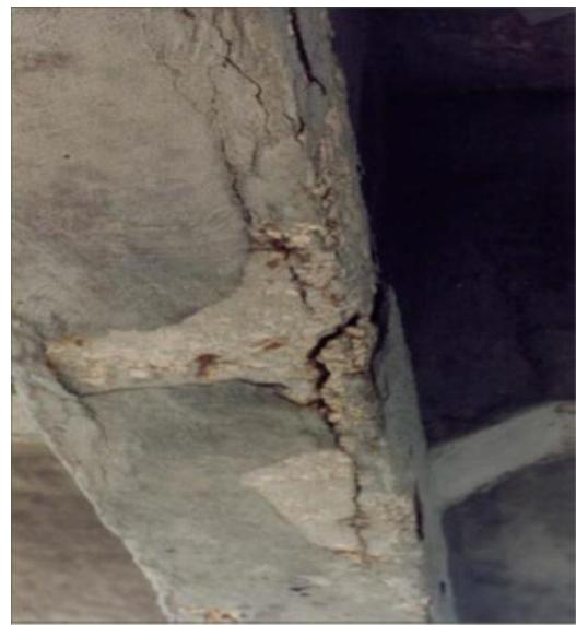
Slika 3.12. Primjeri oštećenja prilikom korozije
