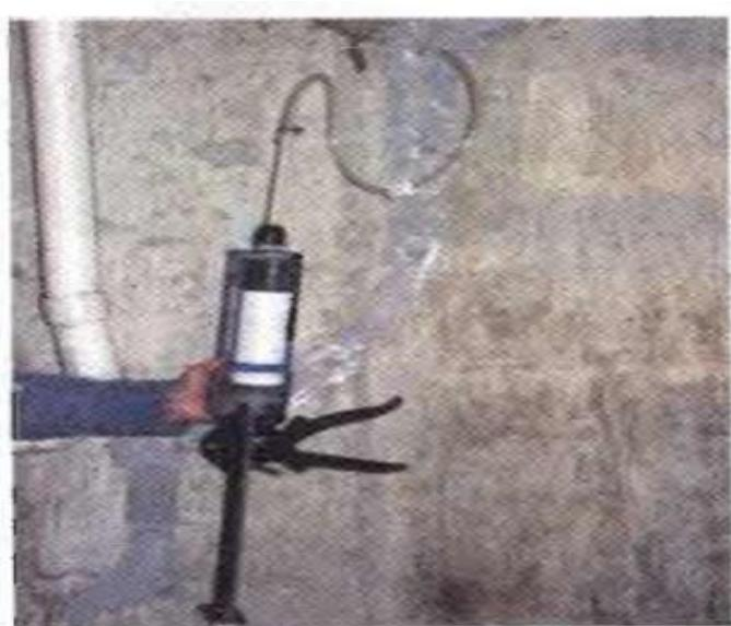
Slika 4.9. Oprema za injektiranje smole
