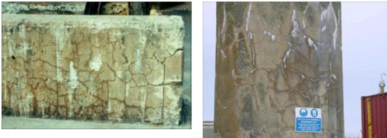
Slika 3.4. Primjeri oštećenja prilikom alkalno – silikatne reakcije
