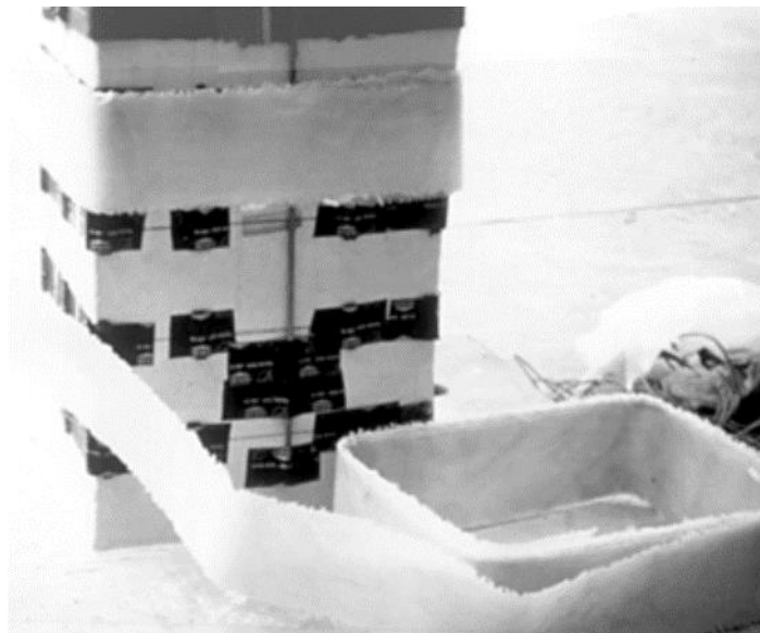
Slika 4.19. Omotavanje kontinuiranog FRP kompozitnog prstena u mnoštvo slojeva oko oštećene zone stupa
