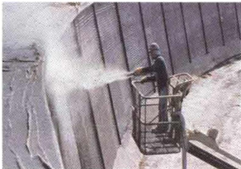
*Slika 4.13. Postupak nanošenja hidrofobne impregnacije prskanjem*
