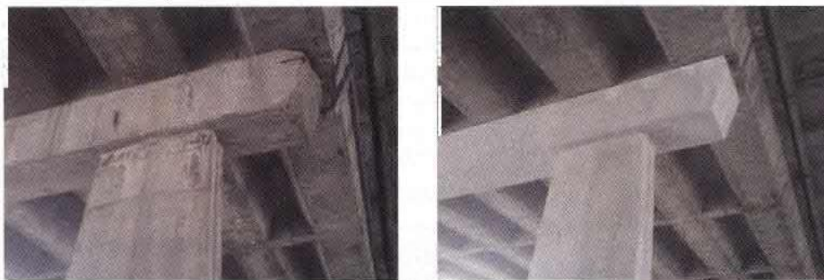
Slika 4.5. Popravak naglavne grede i stupa nadvožnjaka reprofilacijom
