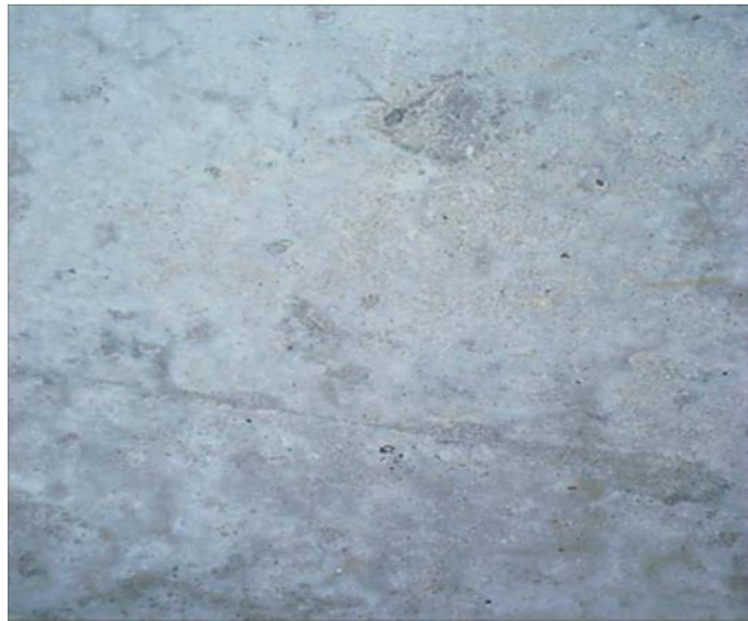
Slika 3.13. Pojava mikropukotina
