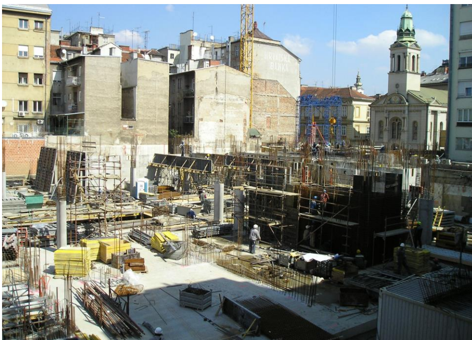
Slika 2.3. Izvedba radova na zgradi Cvjetni prolaz u Zagrebu
