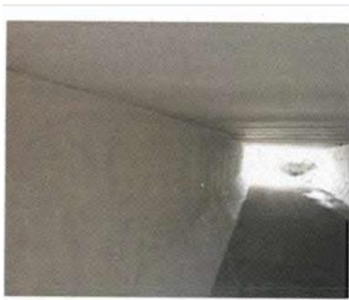
Slika 4.14. Betonska površina prije nanošenja premaza
