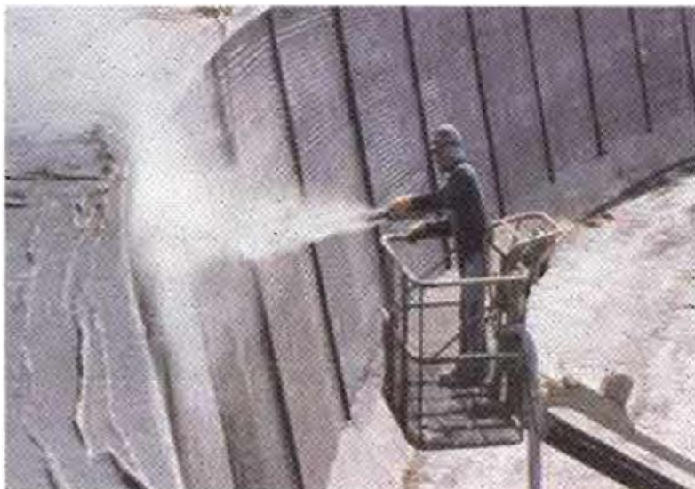
Slika 4.13. Postupak nanošenja hidrofobne impregnacije prskanjem
