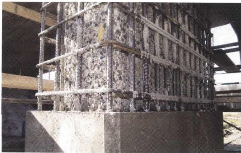
Slika 4.3. Pripremljena površina betona i armature za nanošenje sloja novog morta
