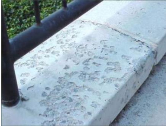
Slika 3.3. Primjeri oštećenja prilikom smrzavanja i odmrzavanja
