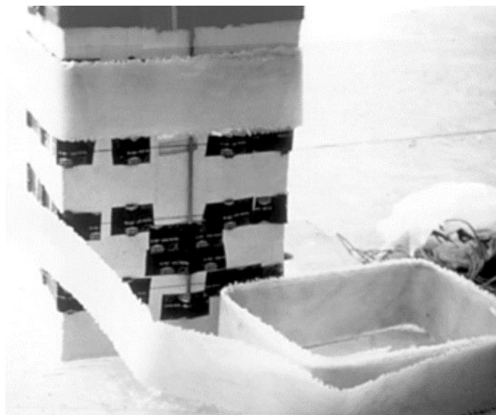
Slika 4.19. Omotavanje kontinuiranog FRP kompozitnog prstena u mnoštvo slojeva oko oštećene zone stupa
