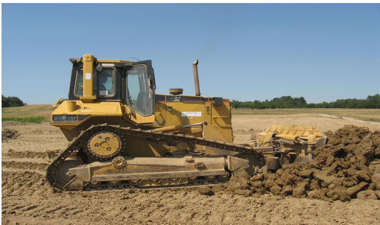
Slika 9. Buldožer za guranje iskopanog tla na manje udaljenosti
