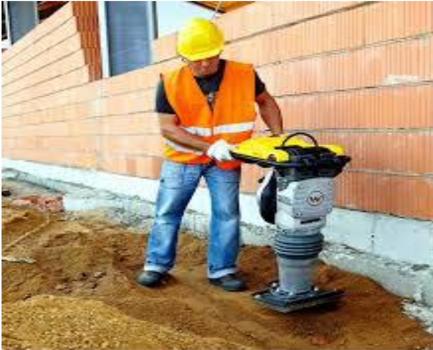
Slika 20. Vibro nabijač za zbijanje oko gotovih građevina
