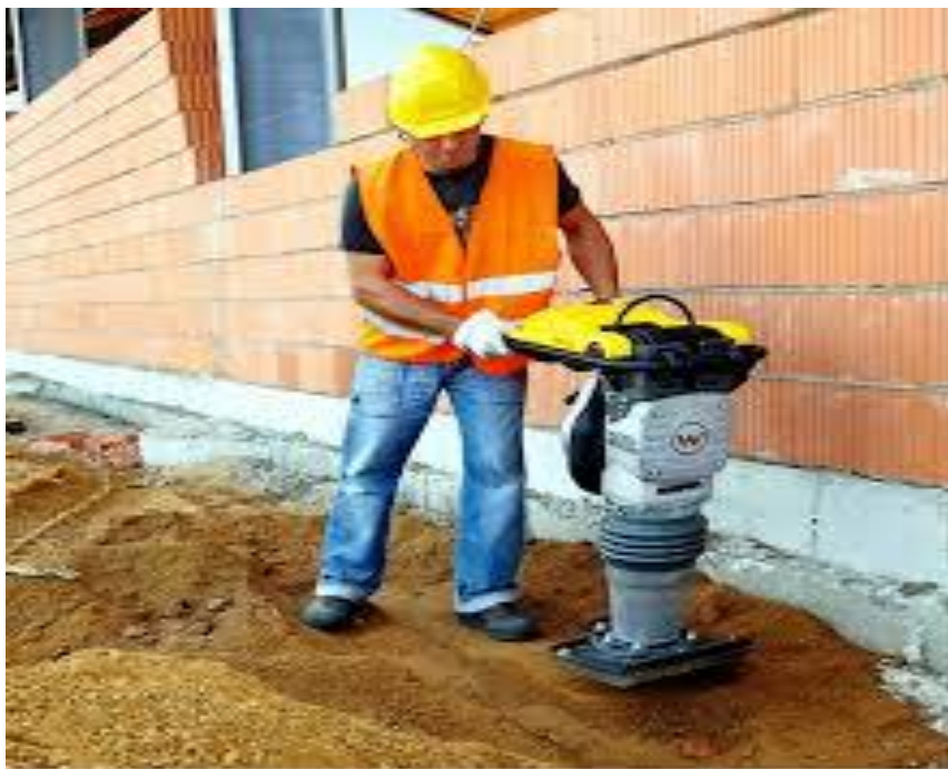
Slika 20. Vibro nabijač za zbijanje oko gotovih građevina
