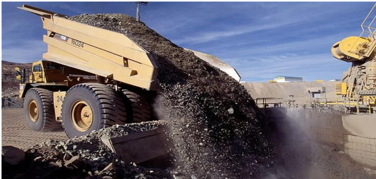
Slika 15. Odlaganje s grubim razastiranjem iz dampera
