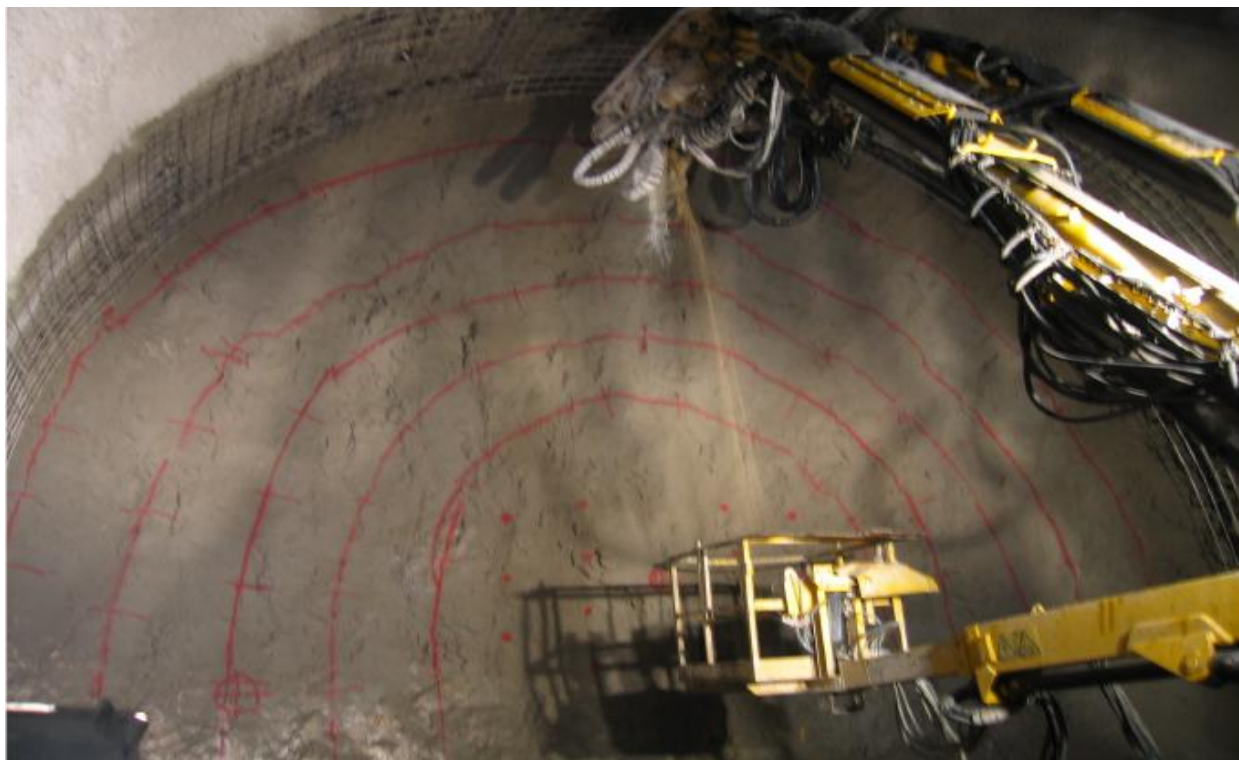
Slika 5. Bušenje minskih bušotina u tunelu
