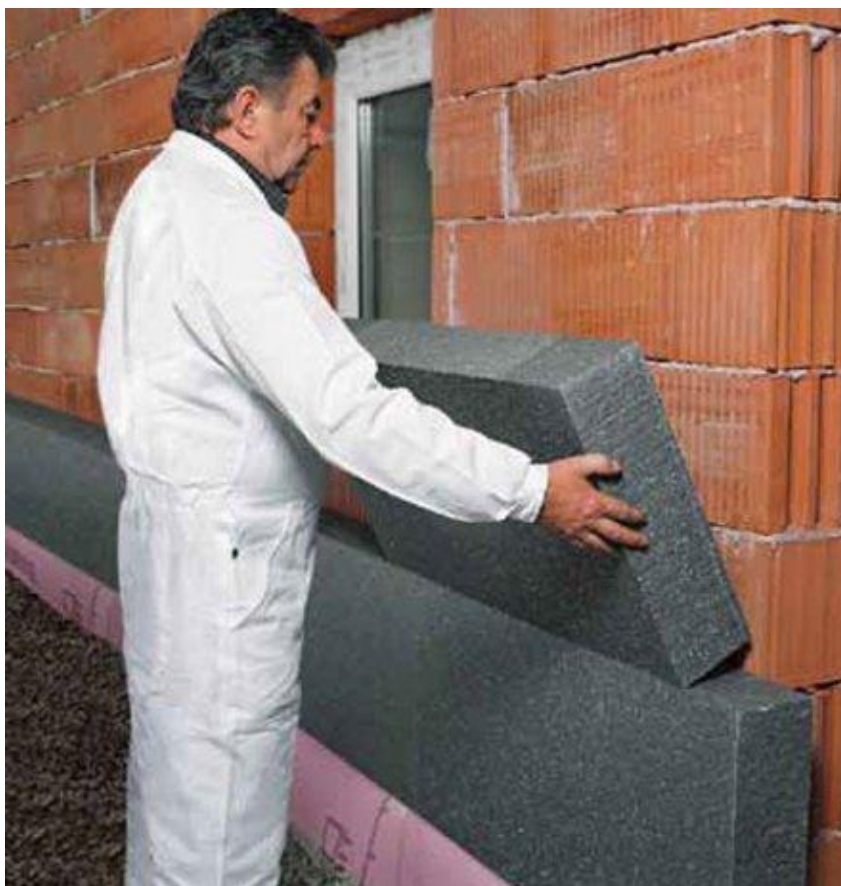
Slika 5. Ugradnja sivog stiropora
