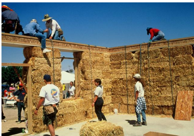
Slika 18. Izrada kuće od slame
