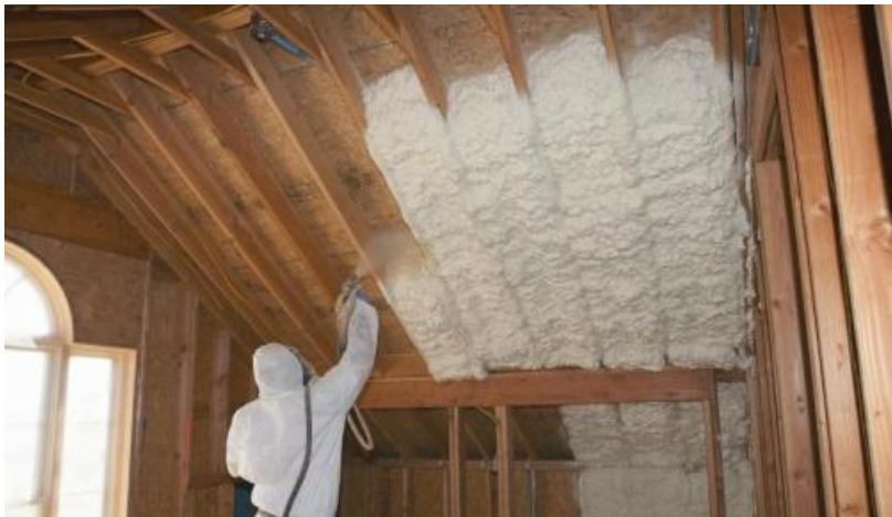
Slika 12. Izvedba termoizolacije krova sa poliuretanskom pjenom
