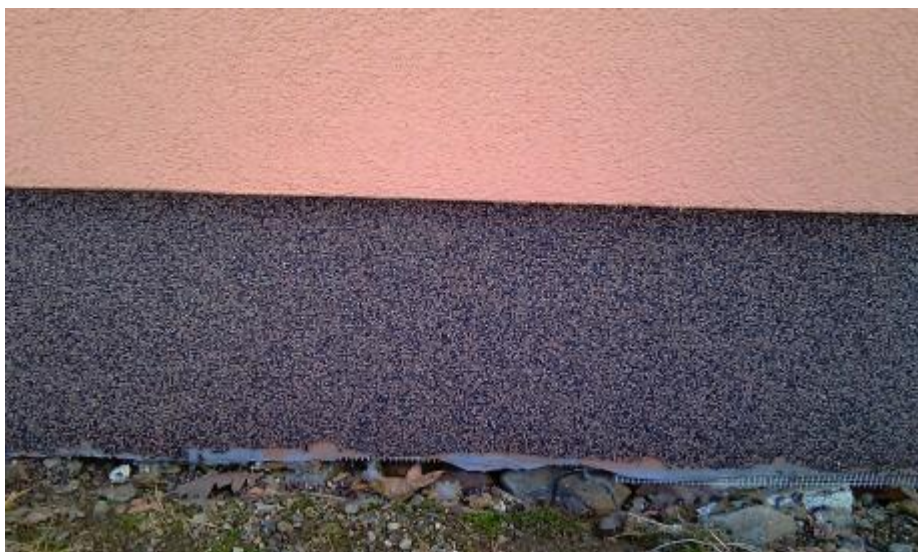
Slika 8. Sokl sa mozaik žbukom
