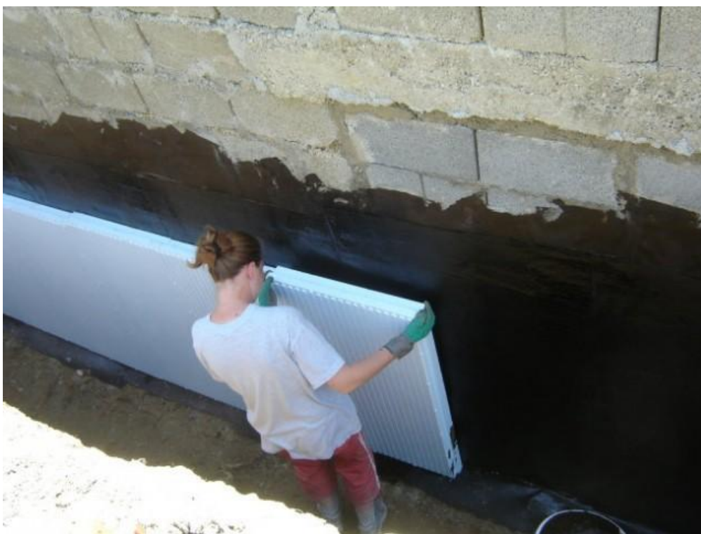
Slika 6. Polaganje stirodur ploča
