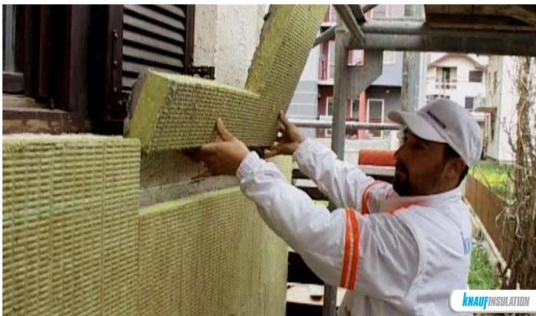
Slika 10. Postavljanje kamene vune oko prozora
