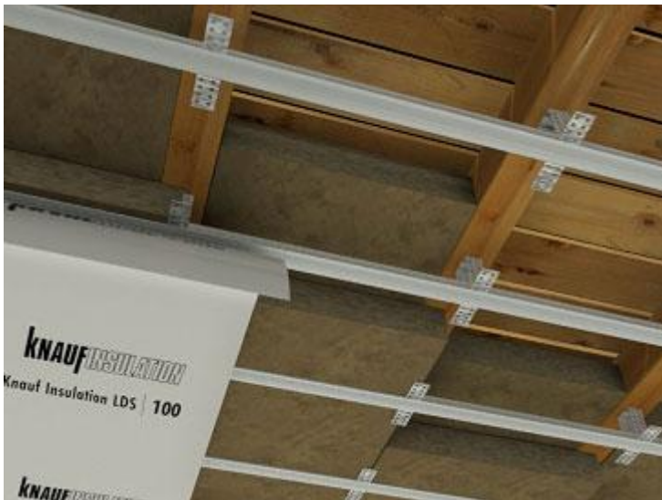
Slika 11. Izvedba kosog krova sa mineralnom vunom
