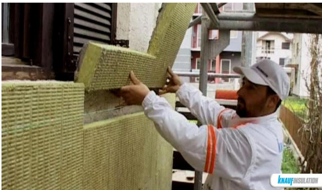
Slika 10. Postavljanje kamene vune oko prozora
