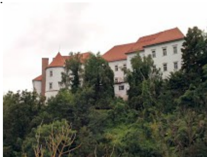
slika 4.1 Zavod Hrastovec – Trate(2)
