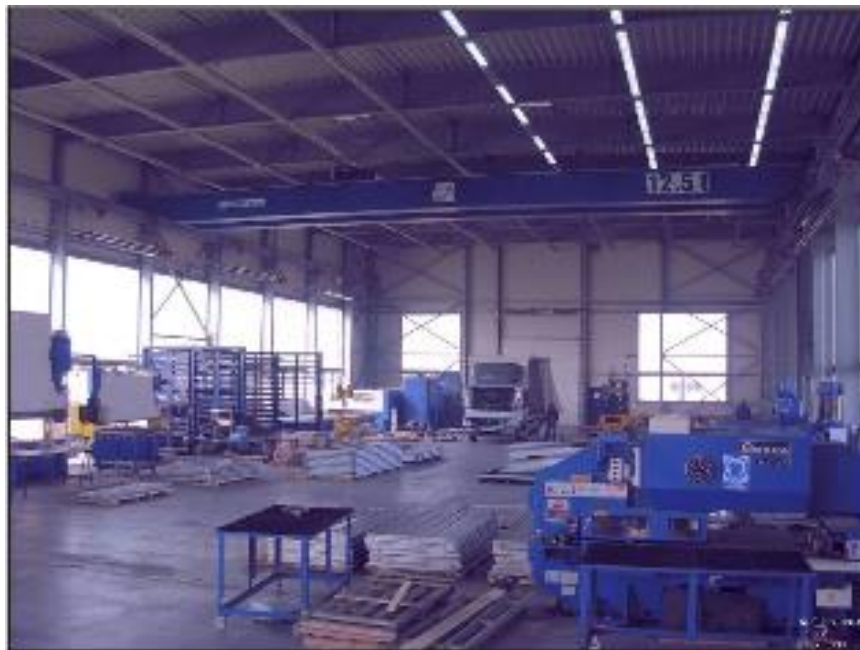
Slika 4.21.b) Unutrašnjost hale (pogled na drugu stranu)
