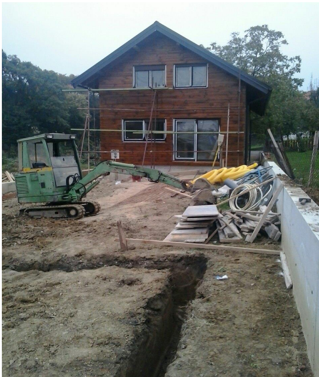
Slika 6.5 Zemljani radovi za elektroinstalacije
