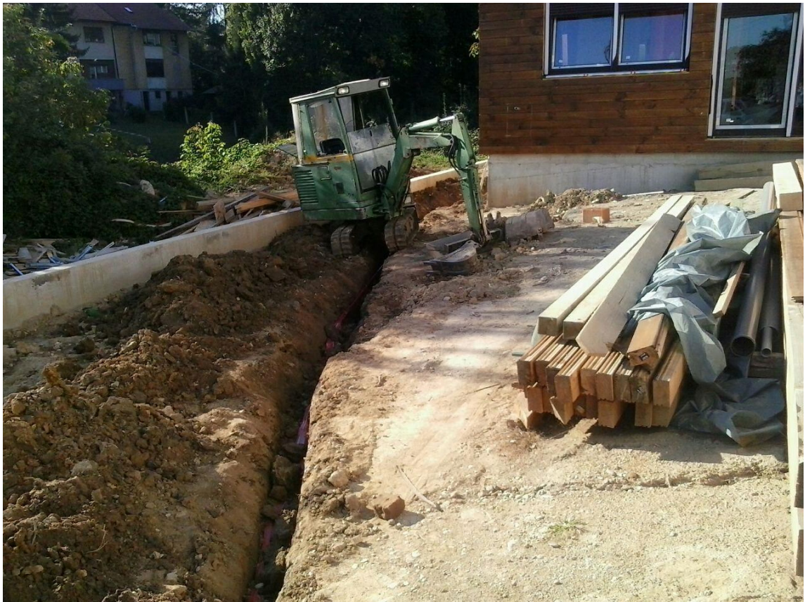
Slika 6.3 Zemljani radovi za elektroinstalacije
