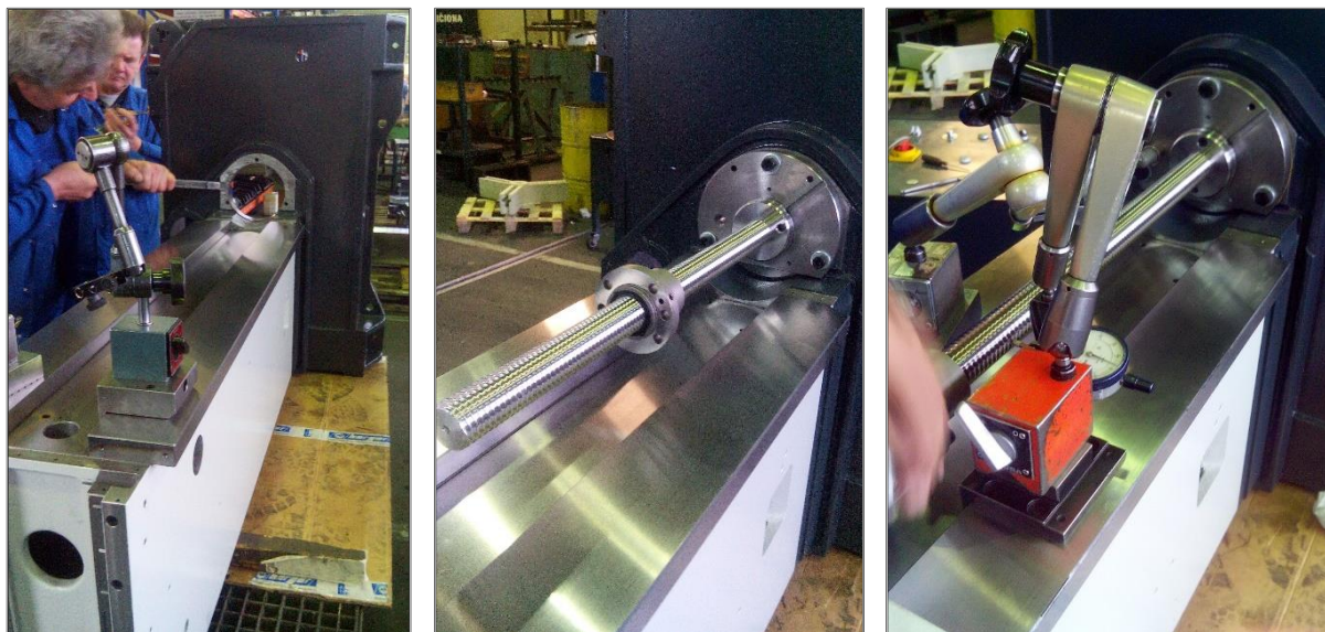
Slika 11.1: Montiranje i podešavanje vertikalnog KNV
