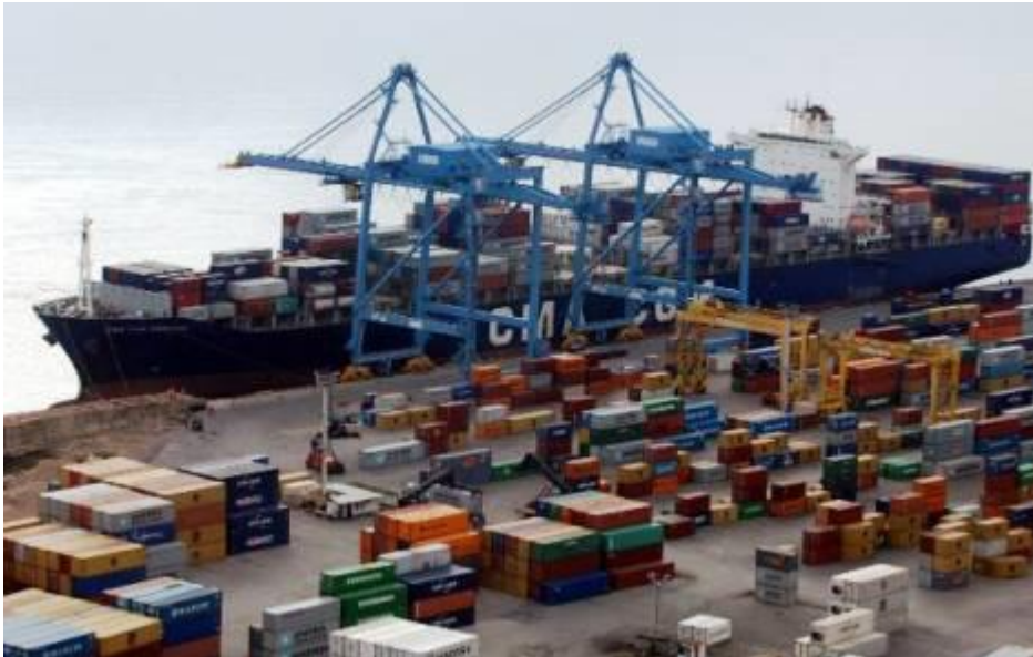
Slika 6. Kontejnerske dizalice „Samsung“ na kontejnerskom terminalu u Rijeci
