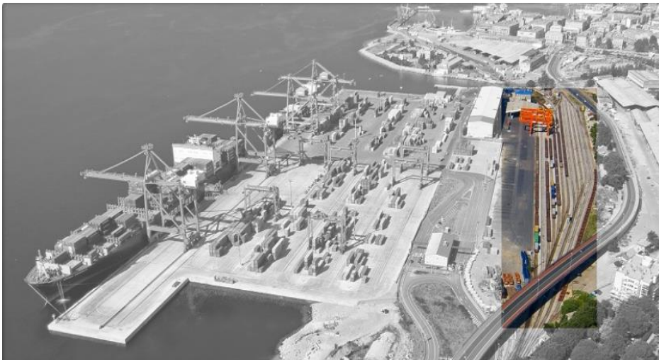
Slika 5. Željeznički dio na terminalu Brajdica (dio u boji)
