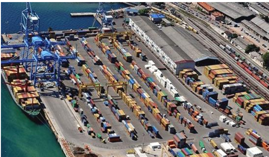
Slika 1. Kontejnerski terminal u Rijeci
