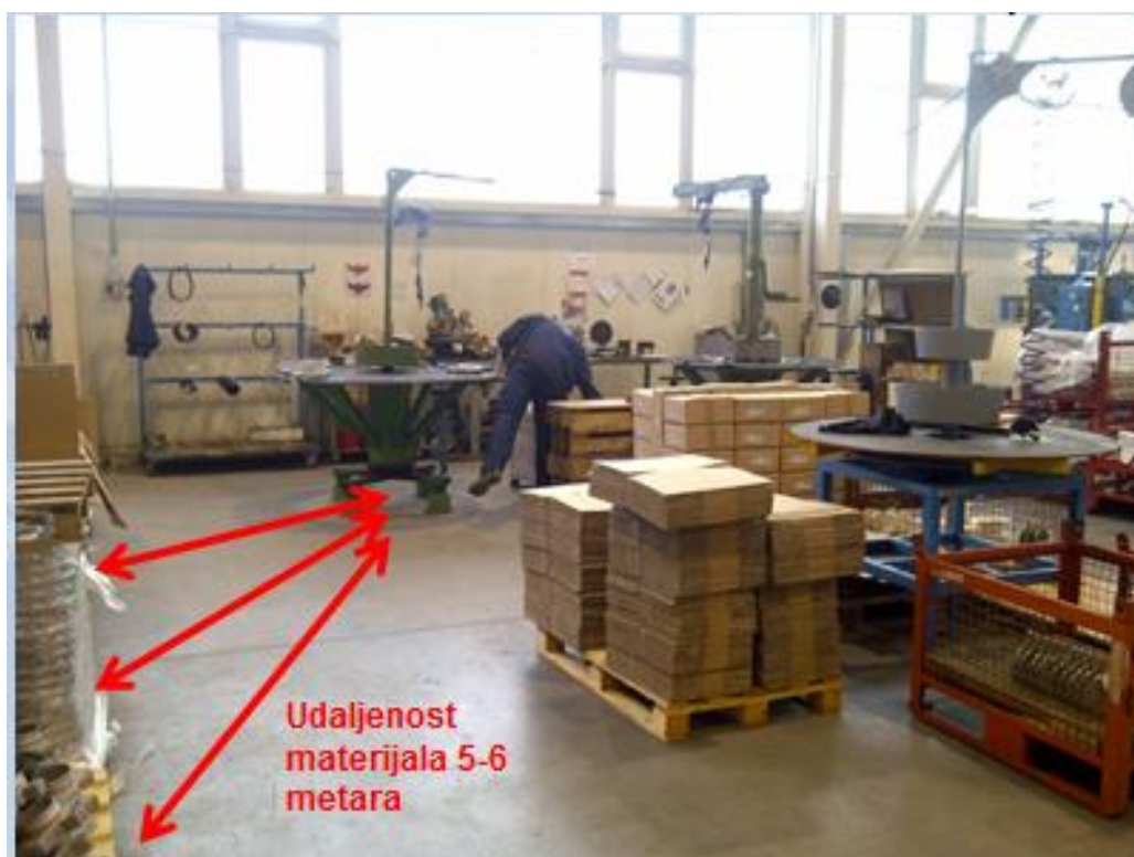
Slika 3.7. Fotografija montaže leptirastih ventila prije prve faze implementacije [28]
