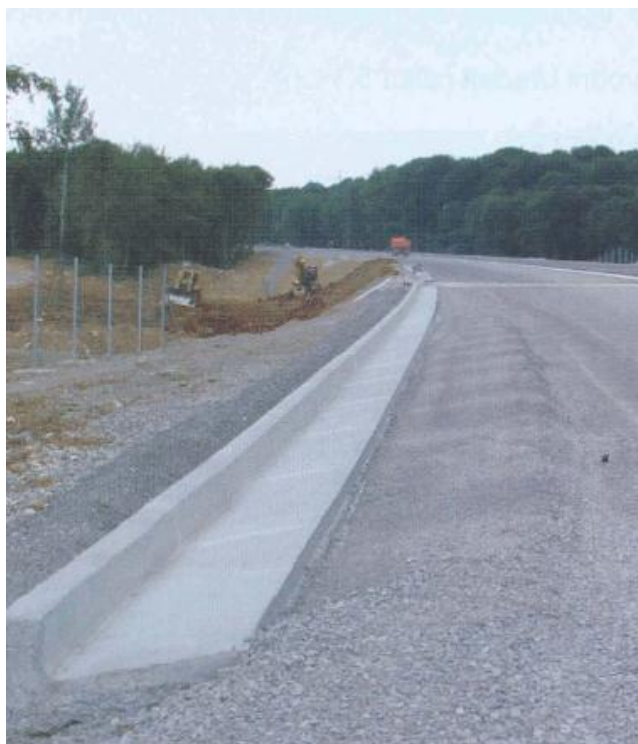
Slika 4.6: Betonski trokutasti rigol (Rezo, 2016.)
