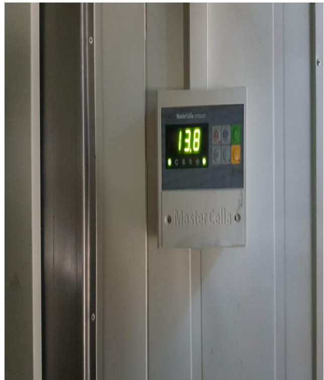
Slika 4.4.5. Komora za skladištenje mliječnih proizvoda sa pripadajućom kontrolom za regulaciju temperature
