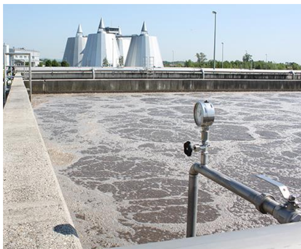
Slika 12. Bazeni za biološku obradu otpadne vode metodom aktivnog mulja
