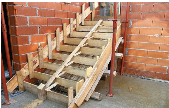
Slika 3.4.1. Izrada oplate za stubište
