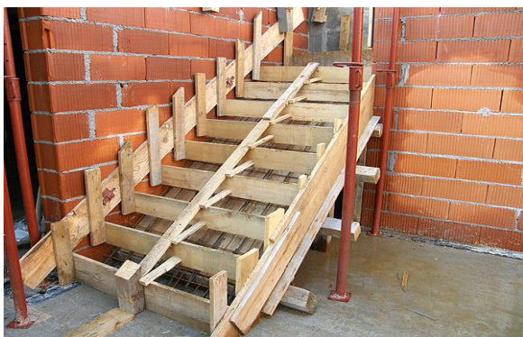
Slika 3.4.1. Izrada oplate za stubište
