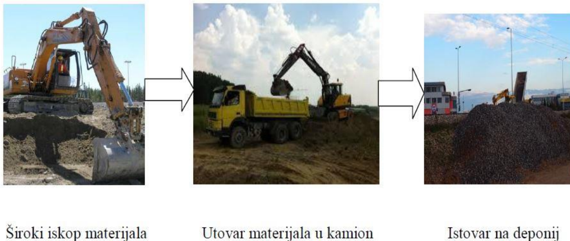
Slika 3.1. Prikaz korištenja strojeva za zemljane radove
