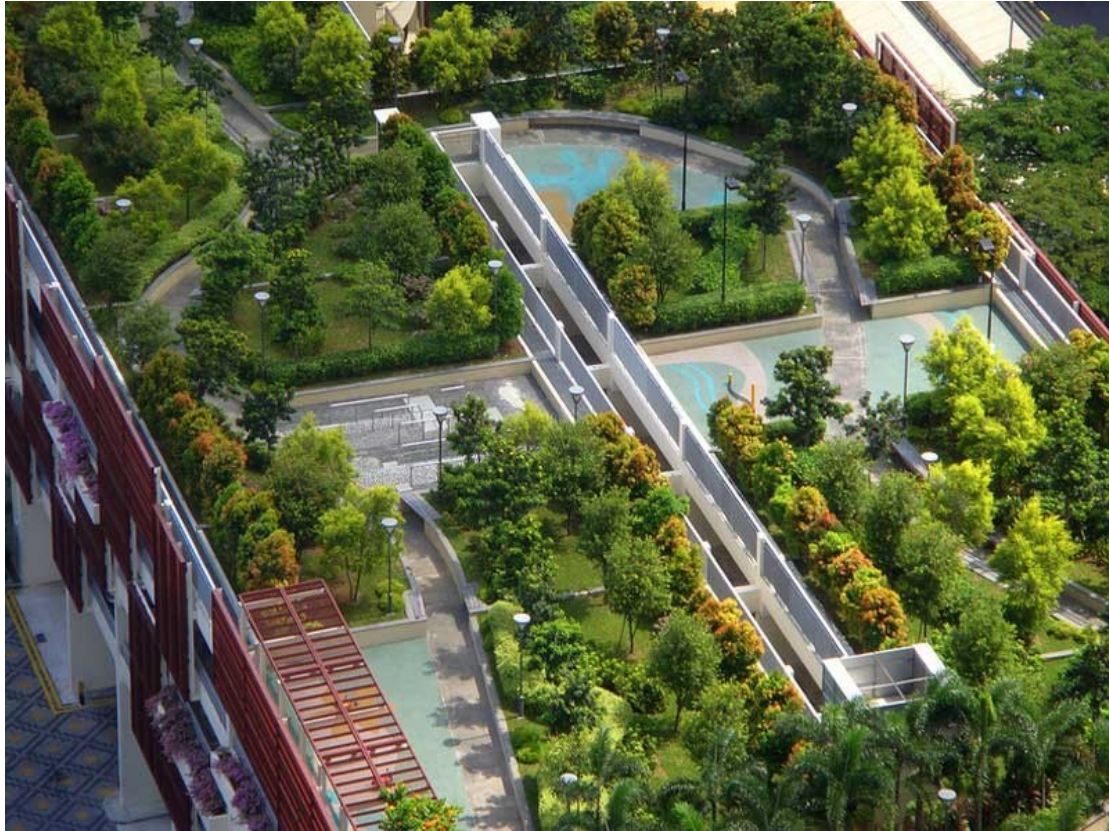
Slika 5. Primjer intenzivnog zelenog krova
