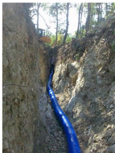
Slika 4.4.2.2. Zemni kolektor obiteljske kuće „Vilić“ u Buzetu
