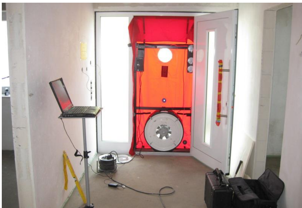
Slika 4.5.1. Ispitivanje blower door testom
