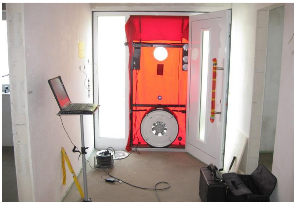
Slika 4.5.1. Ispitivanje blower door testom
