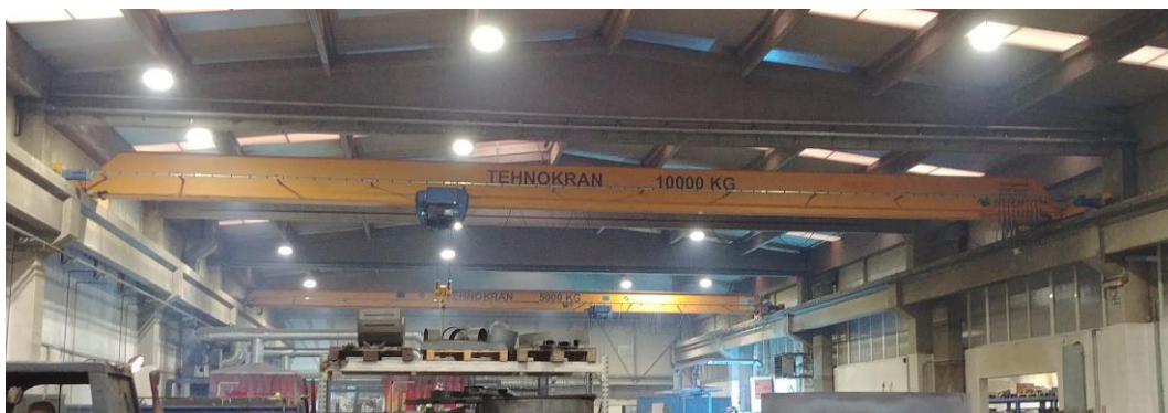
Slika 4. Kranovi u zavarivačkoj radionici
