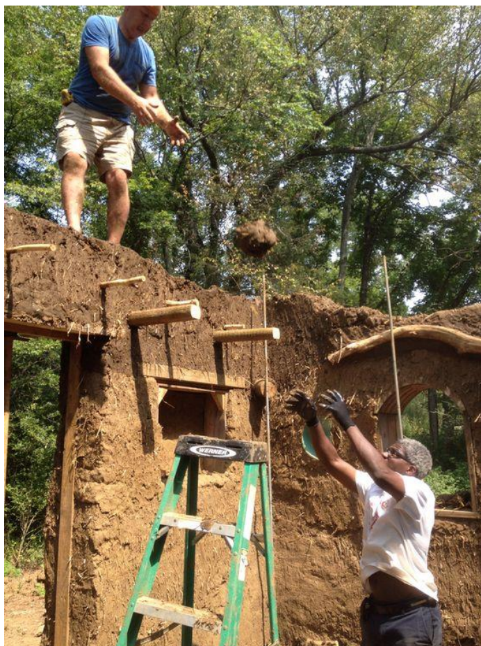
Slika 10 Gradnja kuće cobom
