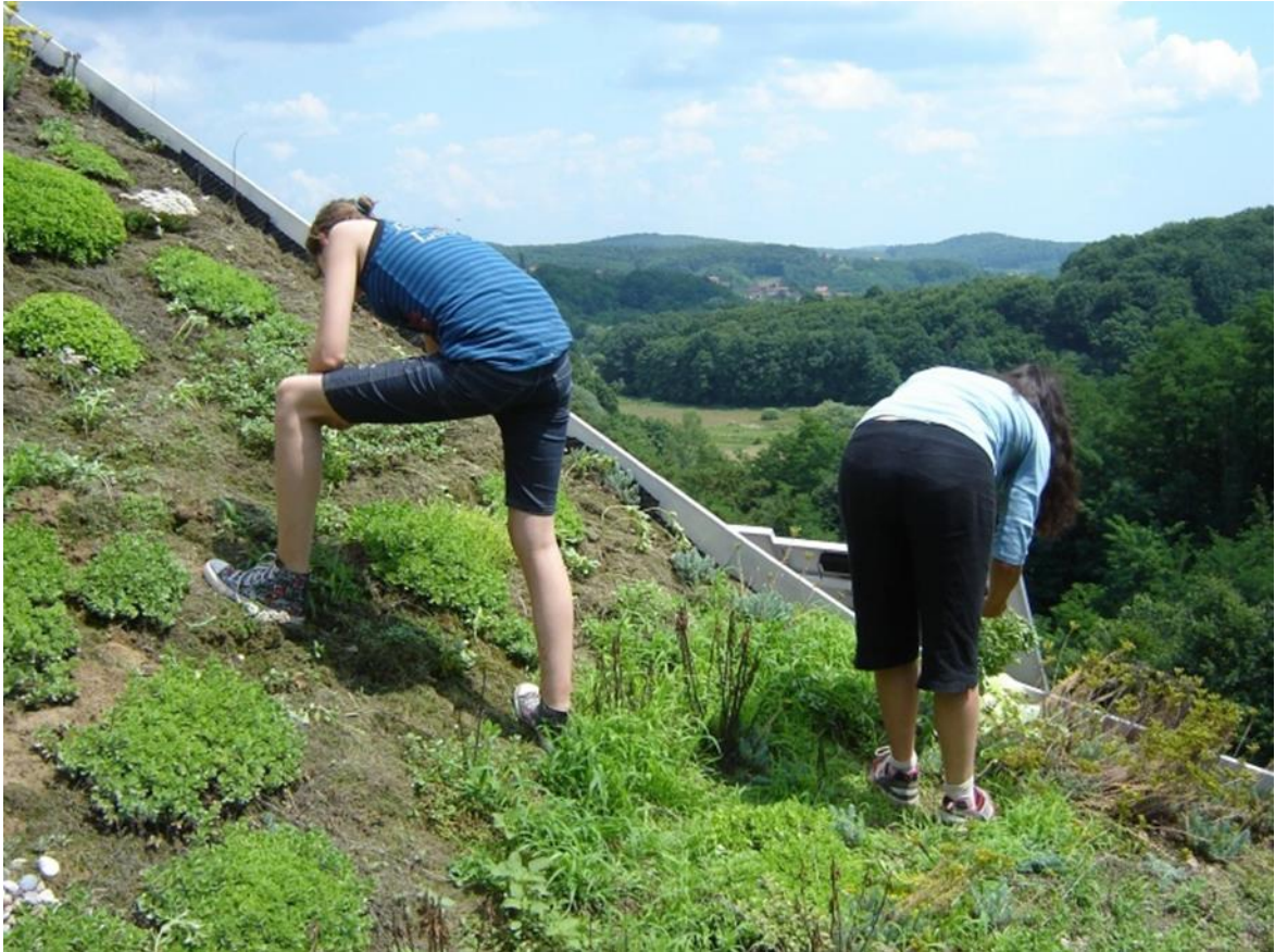
Slika 30 Sadnja biljaka na krovu
