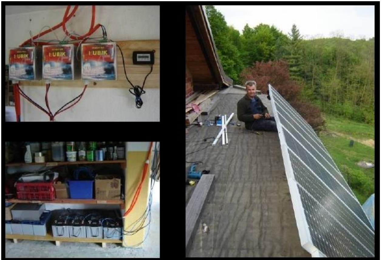
Slika 27 Postavljanje solarnih panela
