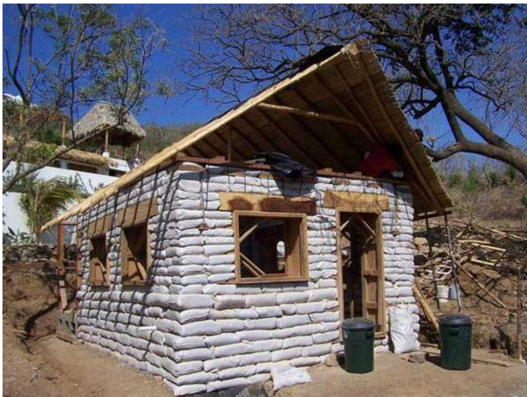
Slika 9 Kuća sagrađena od vreća napunjenih zemljom
