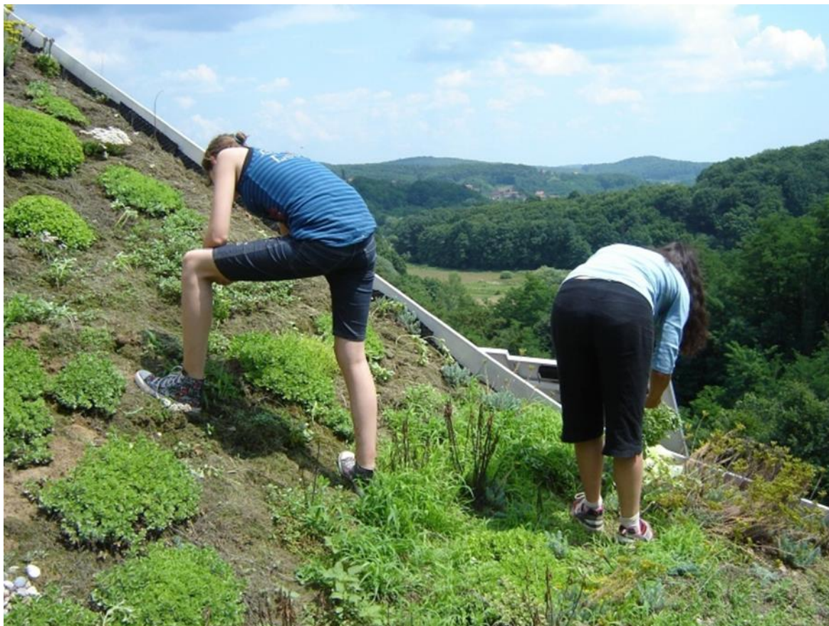
Slika 30 Sadnja biljaka na krovu
