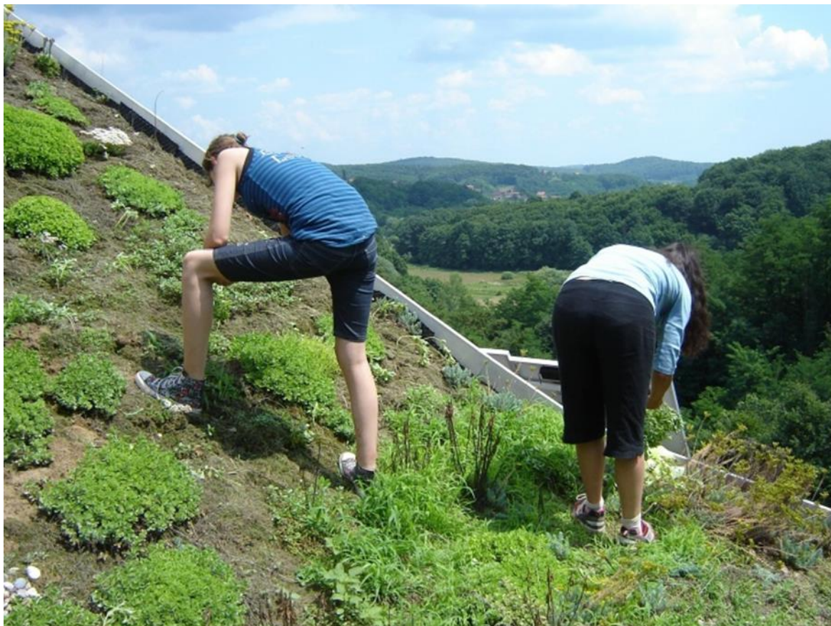
Slika 30 Sadnja biljaka na krovu
