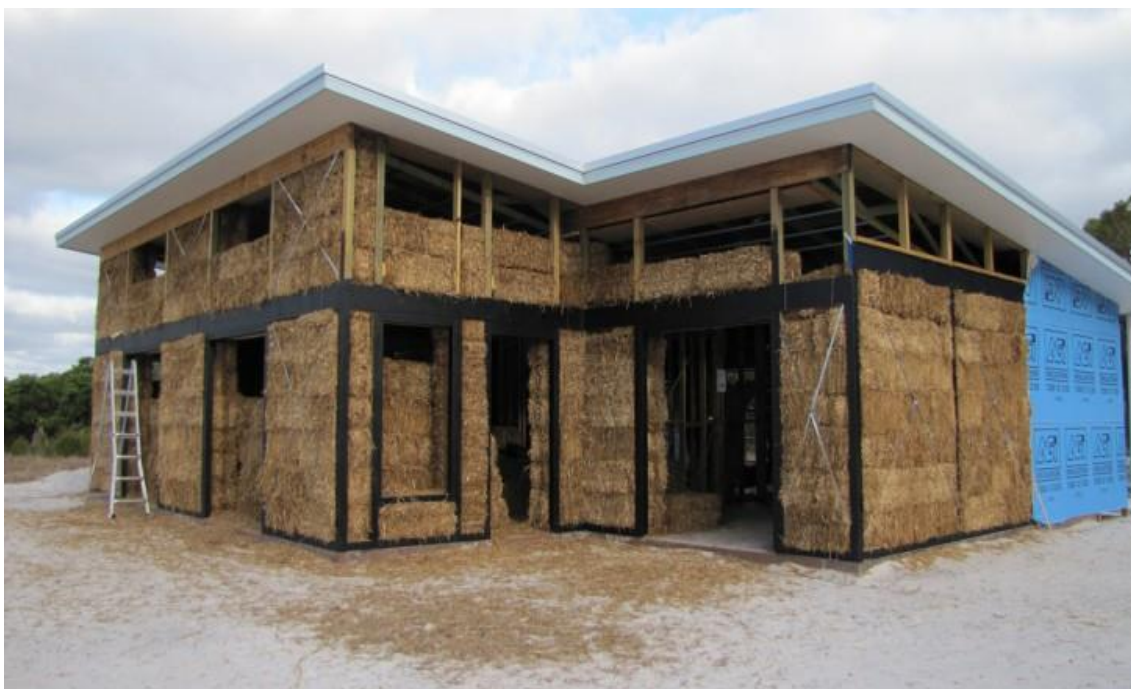
Slika 5. Kuća građena slamom kao izolacijski materijal
