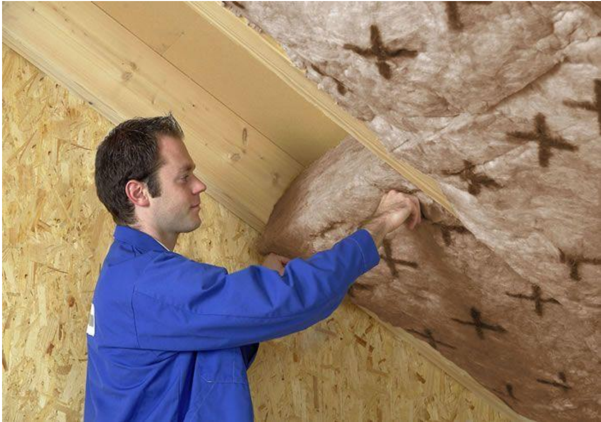
Slika 13. Ugradnja staklene mineralne vune u drveni okvir
