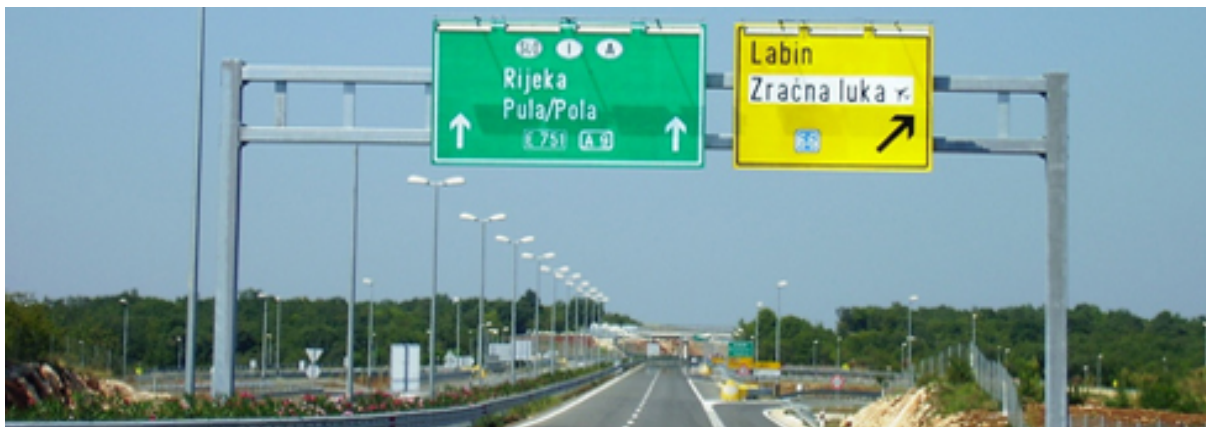
Slika 8.2 Portal na autocesti
