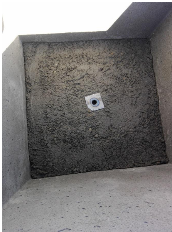
Slika 4.5. Prikaz postavljene čašice u temeljnoj čaši
