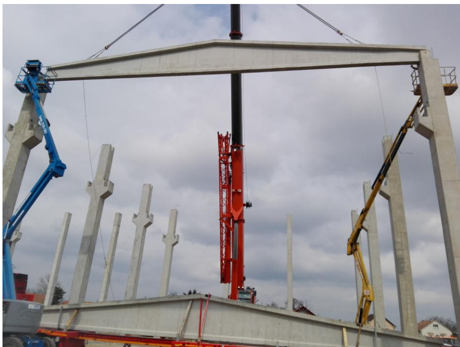
Slika 4.11. Montiranje glavnog krovnog grednog nosača pomoću auto dizalice
