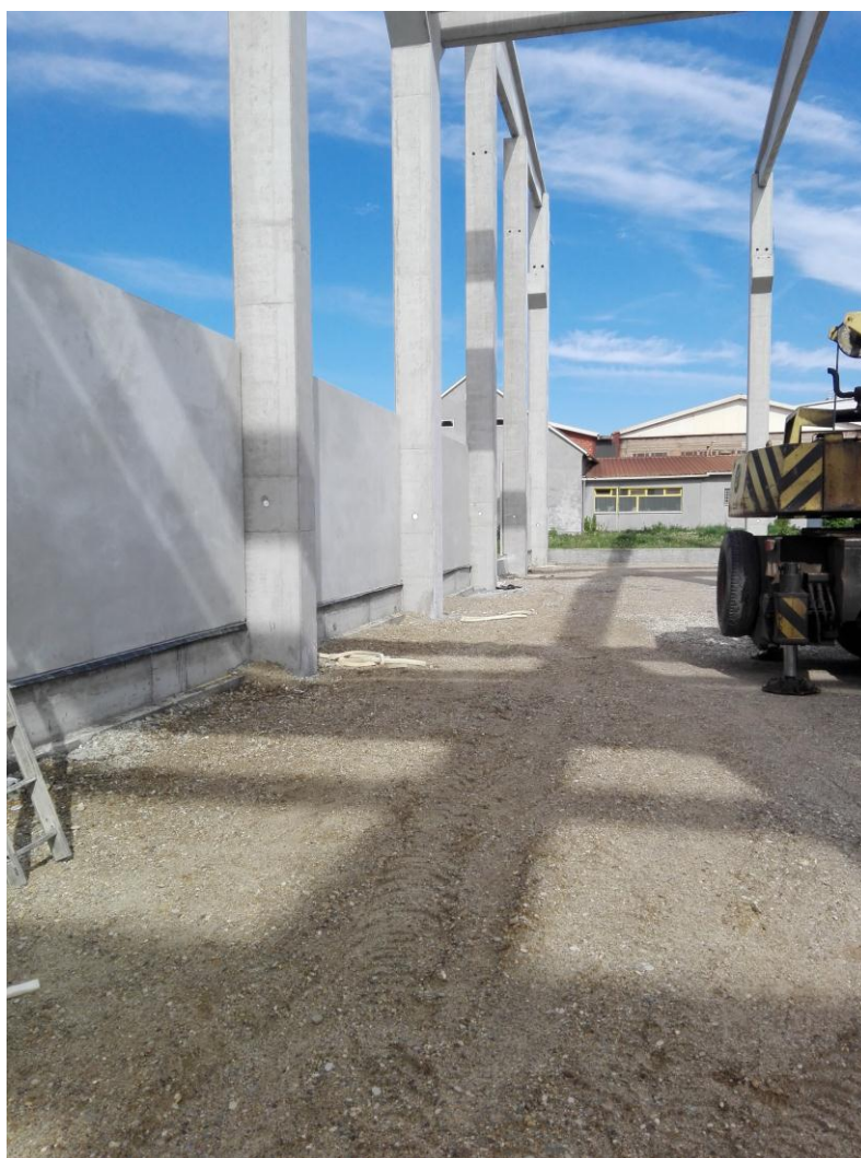
Slika 4.18. Pogled na sjeverno pročelje s unutarnje strane proizvodno poslovne zgrade
