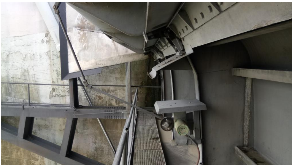
Slika 2.13. Sustav za mjerenje položaja zaklopke
