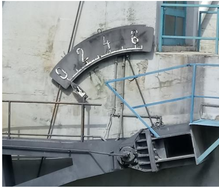
Slika 2.12. Vanjski, mehanički pokazivač položaja
