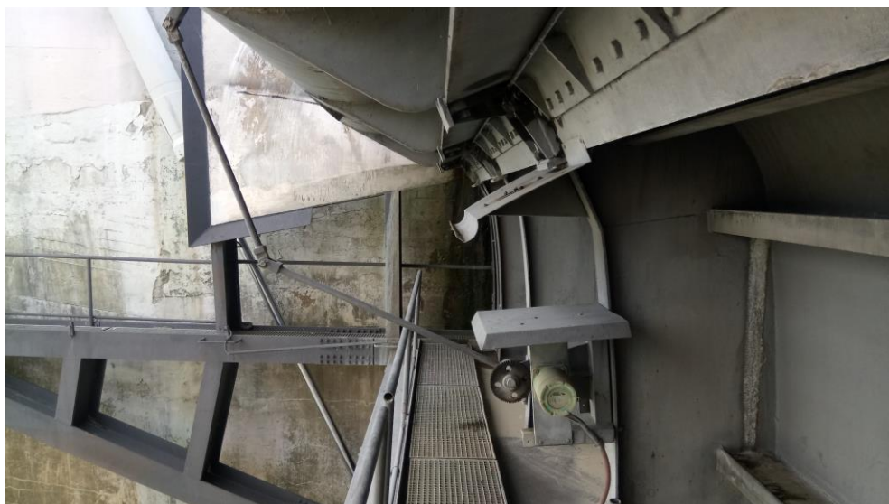
Slika 2.13. Sustav za mjerenje položaja zaklopke
