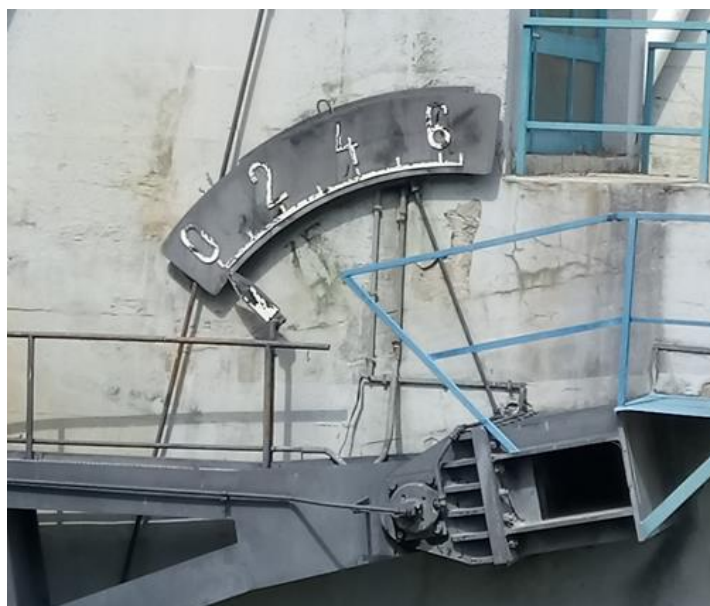
Slika 2.12. Vanjski, mehanički pokazivač položaja
