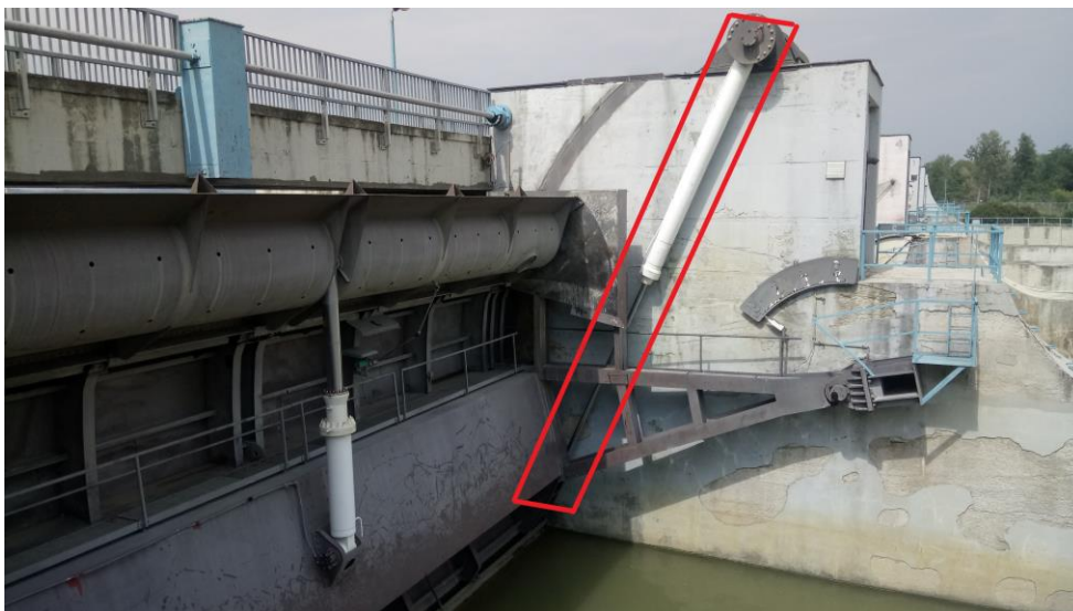
Slika 2.7. Preljevno polje, Servomotor segmentnog zatvarača
