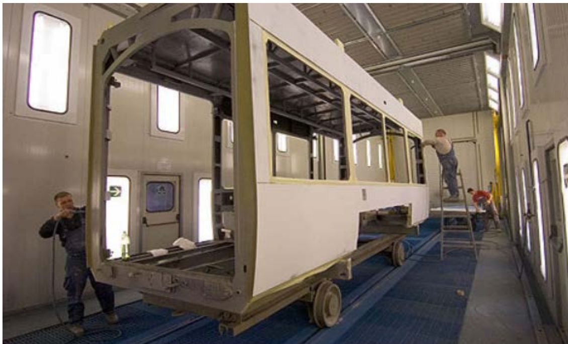
Slika 4.9: Zaštita i lakiranje tramvaja u nadležnosti TŽV "Gredelj"
