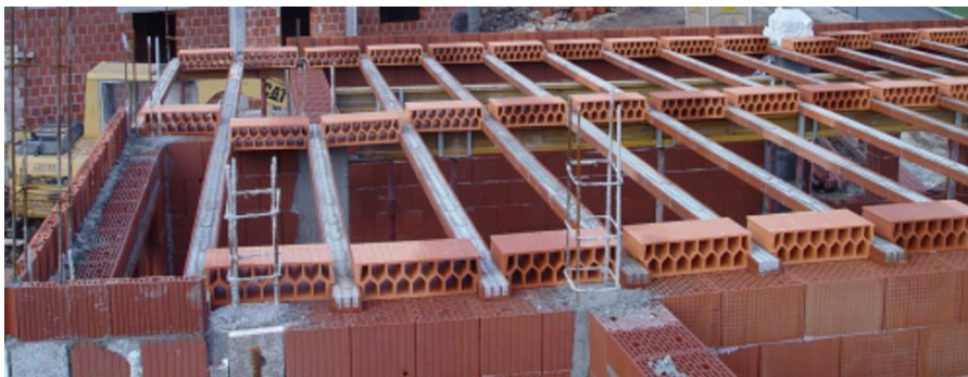
Slika 1.1. – Primjer rebrastog stropa sustava Porotherm
