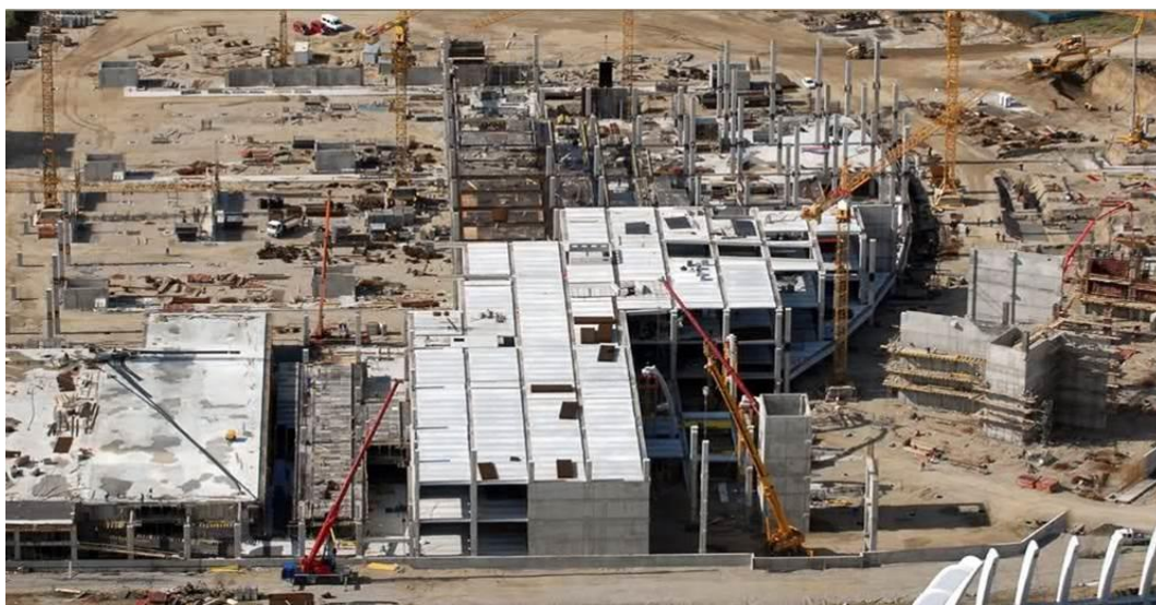
Slika 3.3. Izvođenje, lijevo PT monolit, desno montaža
