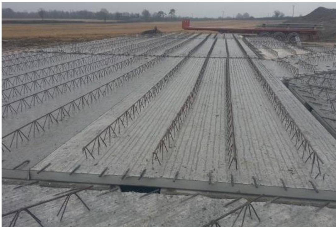
Slika 2.1.7. - Strop od "Omnia" ploča - "Keeganprecast"
