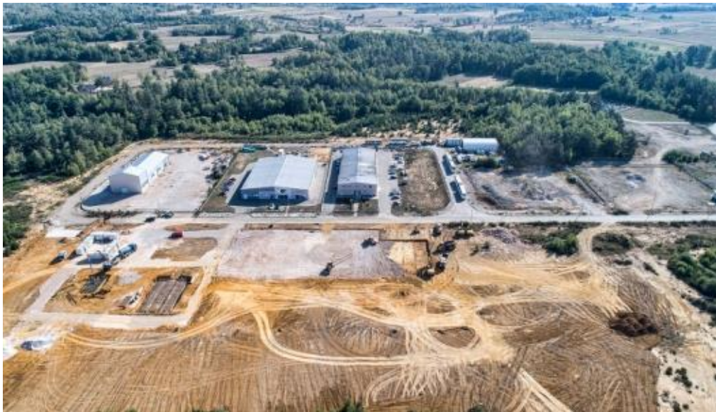
Slika 4 Početak izgradnje energane u Gospiću [14]
