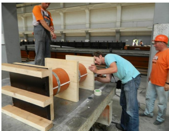
Slika 4. 5 Formirana oplata spremljena za betonažu
