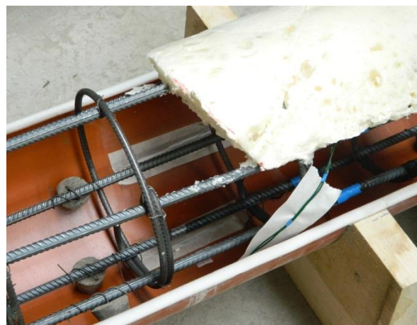
Slika 4. 4 Priprema armaturnog koša za betoniranje
