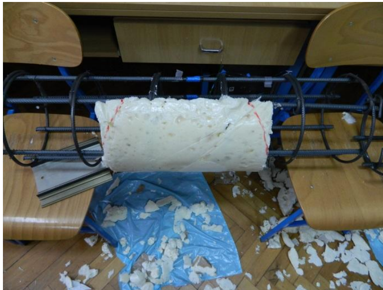
Slika 4. 2Obrada pur pjene na željeni dizajnirani oblik
