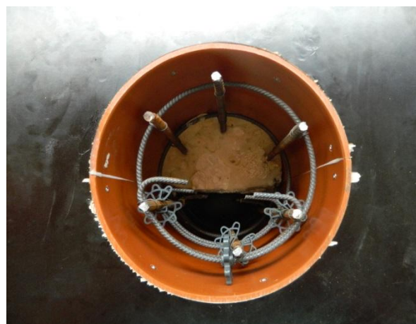
Slika 4. 5 Formirana oplata spremljena za betonažu
