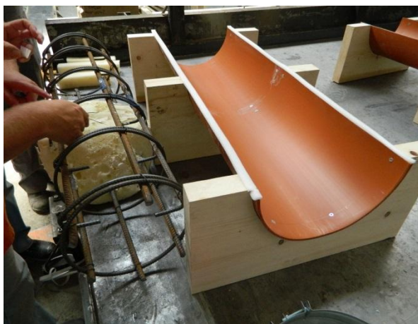
Slika 4. 4 Priprema armaturnog koša za betoniranje
