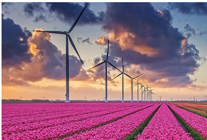
Slika 4.3 Izvedba sa stupom postavljenim iza lopatica [16]
