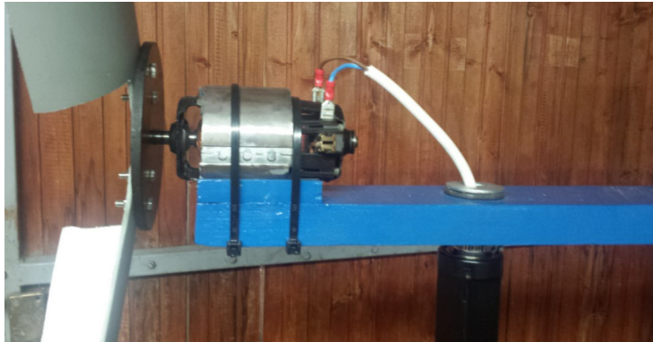
Slika 5.17 Montiranje generatora i postavljanje kabela
