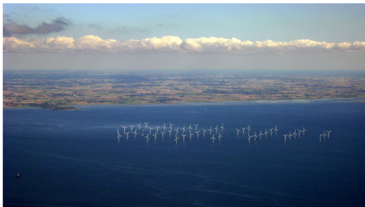
Slika 4.10 Priobalna vjetroelektrana Lillgrund [23]
