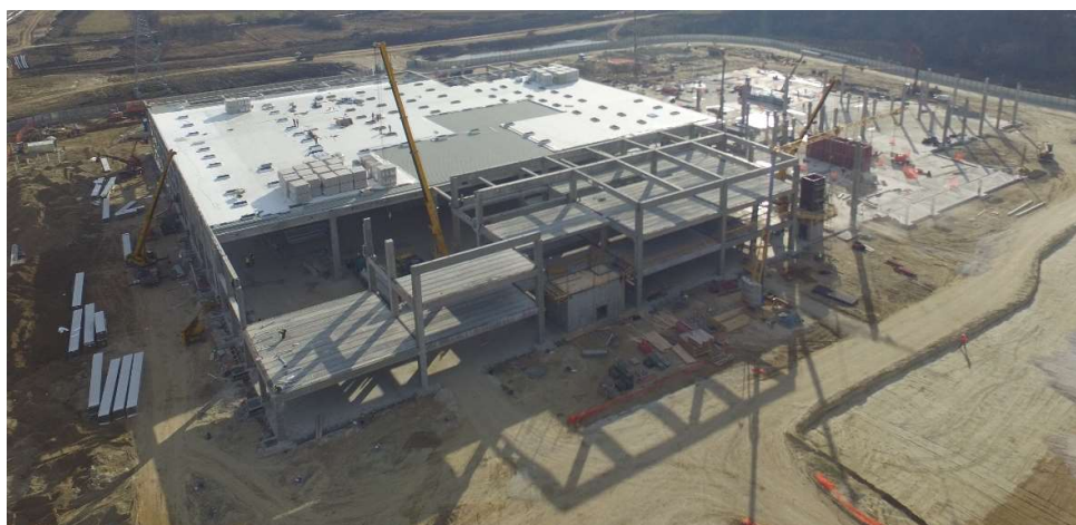
Slika 6.9. Panoramski pogled na gradilište IKEA
