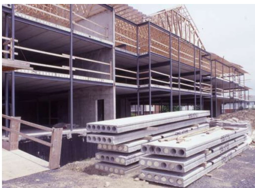
Slika 4.1. Prikazuje pravilno odlaganje ploča na gradilištu
