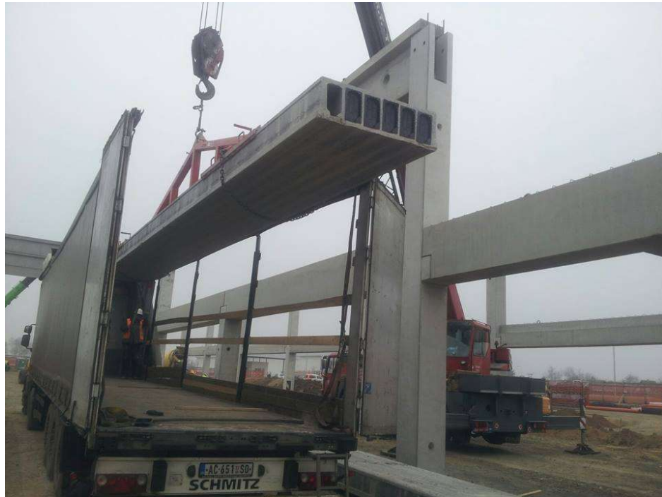
Slika 4.3. Podizanje prednapregnutih ploča
