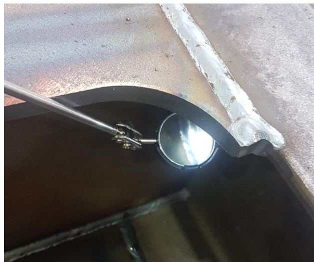
Slika 33. Vizualna kontrola zavarenog spoja
