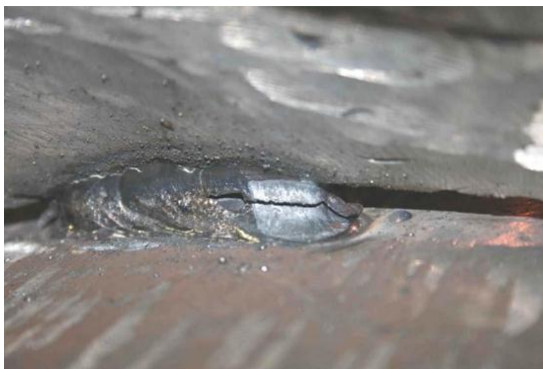
Slika 35. Pukotina u pripojnom zavaru
