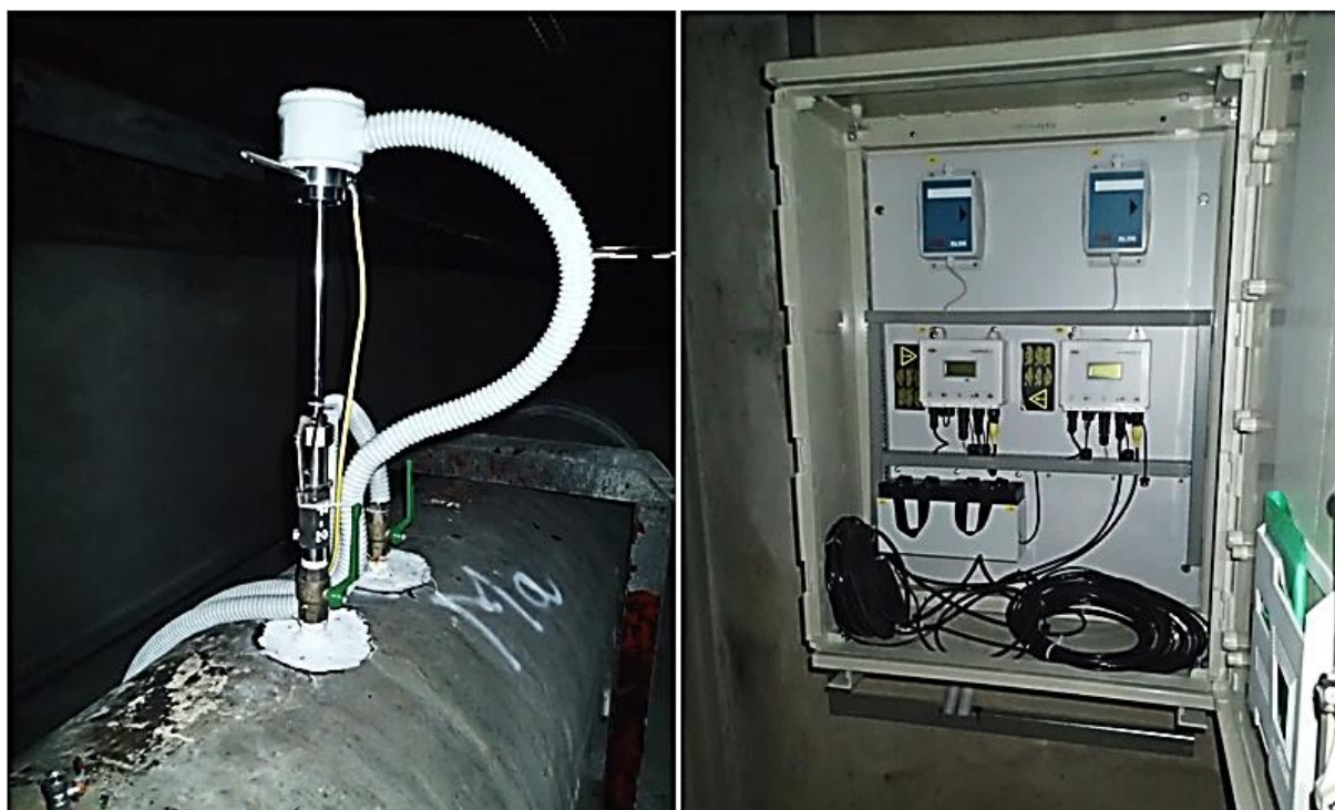
Slika 3.12 AquaProbe FEA 200, Petruševac
