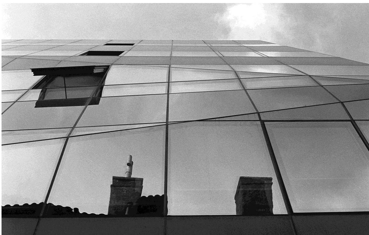
Slika 38: Rijeka, zgrada Medico
