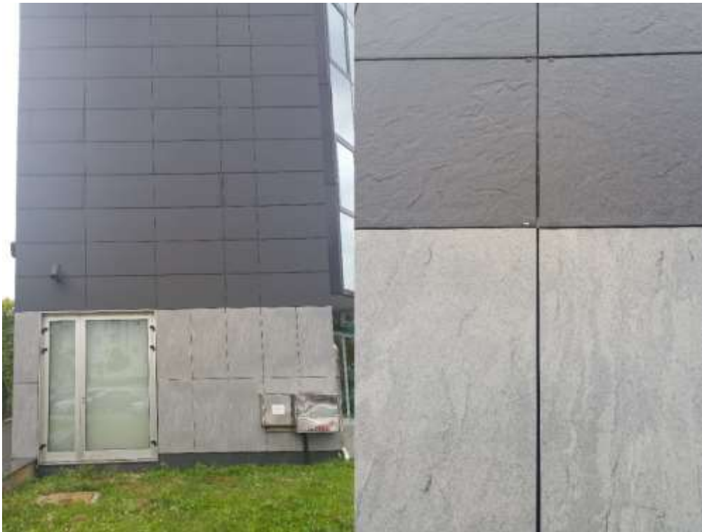
Slika 26. Ventilirajuća kamena fasada Zagrebačka banka Špansko, Zagreb
