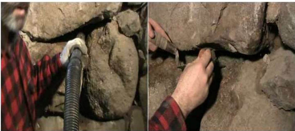
Slika 21. Ubrižgavanje morta mehaničkom pumpom
