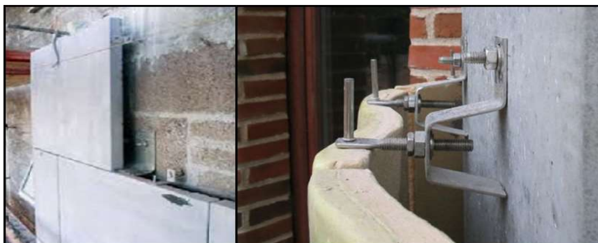
Slika 33. Postavljanje kamenih ploča na pročelje građevine
