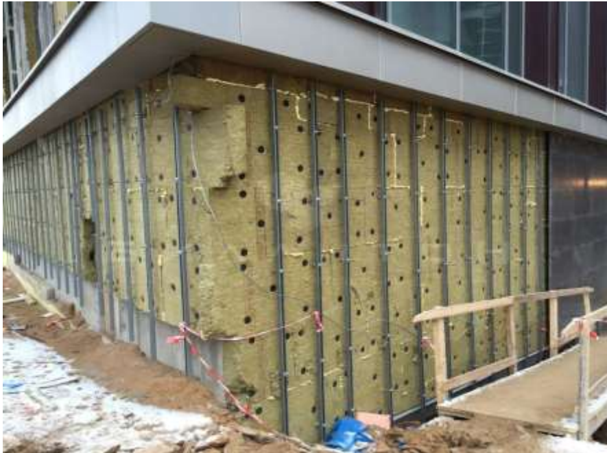
Slika 38. Postavljanje izolacije ispod ploča ventilirane kamene fasade
