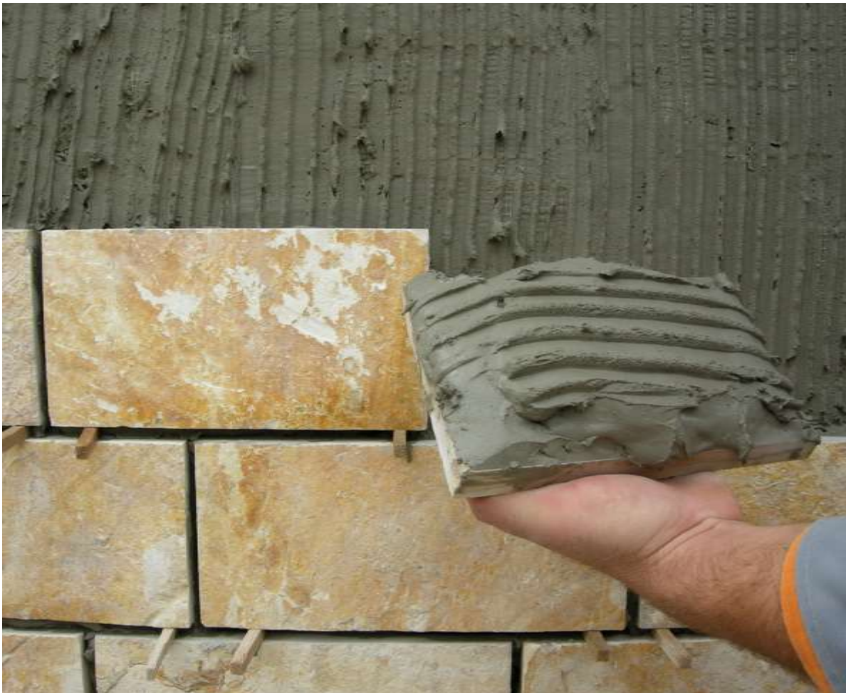
Slika 40. Oblaganje kamenim pločama
