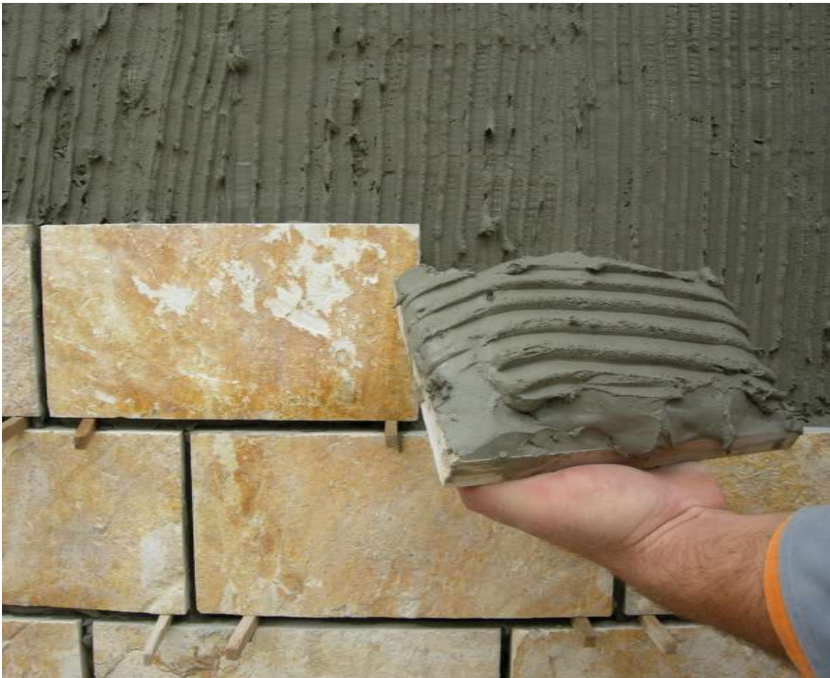
Slika 40. Oblaganje kamenim pločama
