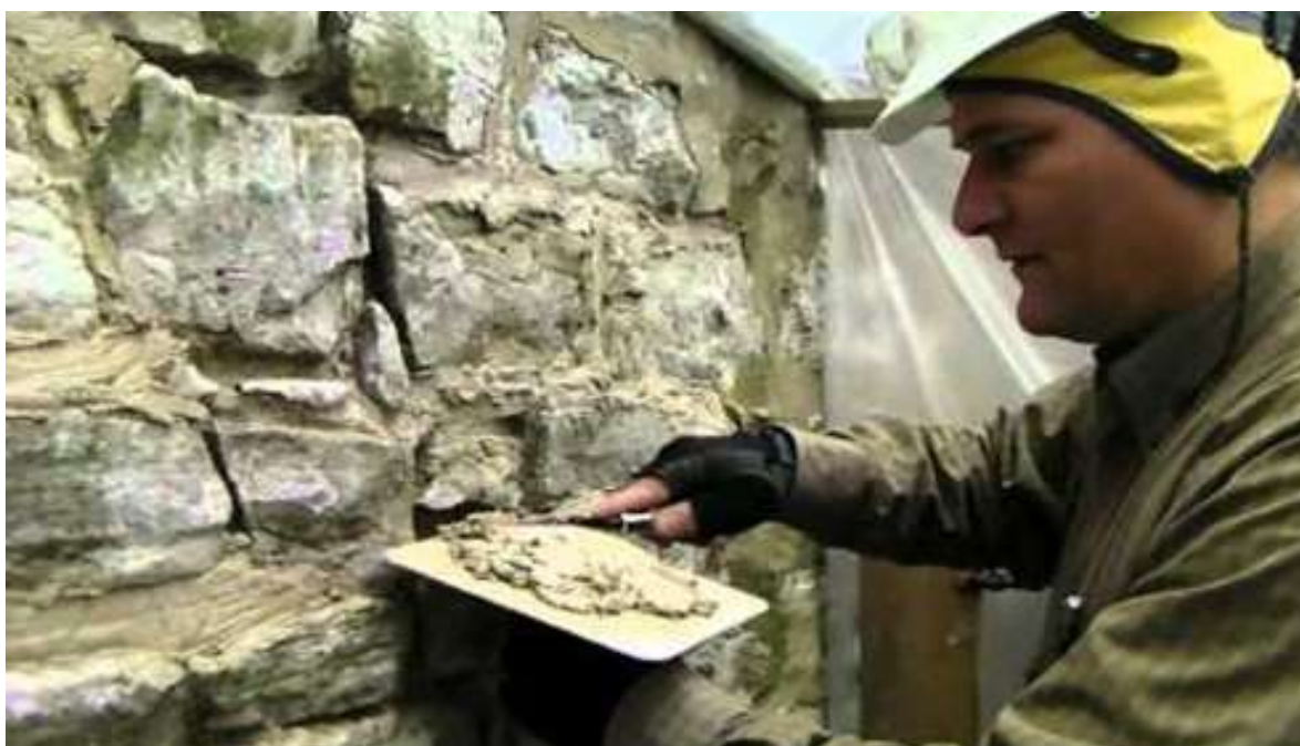
Slika 18. Ručno punjenje fuga
