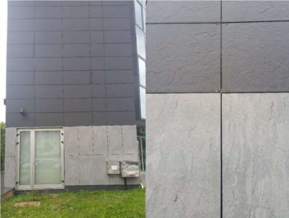
Slika 26. Ventilirajuća kamena fasada Zagrebačka banka Špansko, Zagreb
