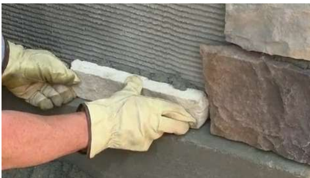
Slika 24. Horizontalno nazubljena podloga zupčastim gleterom
