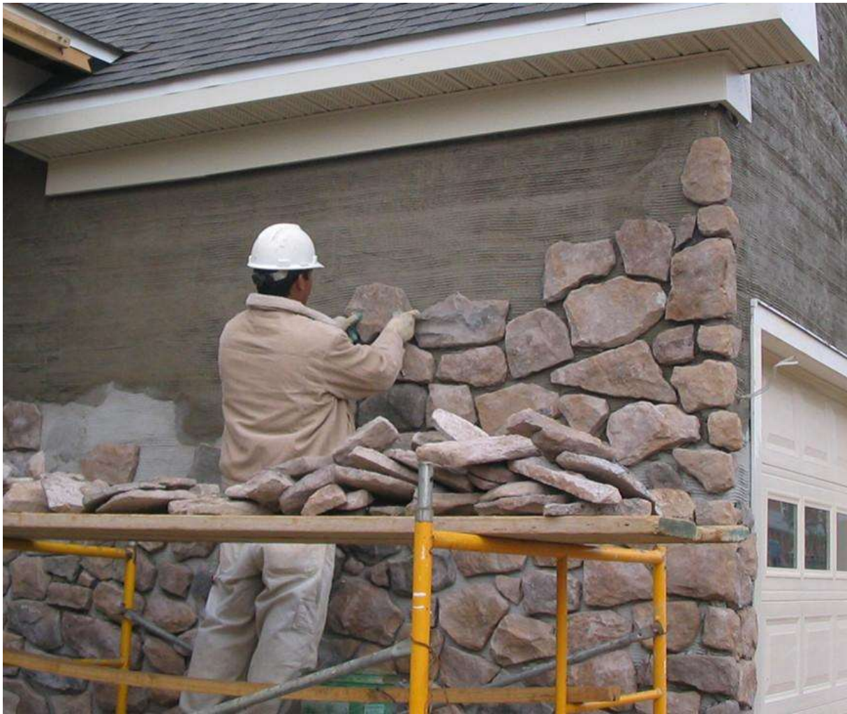
Slika 19. Postavljanje kamenih ploča na hrapavu površinu
