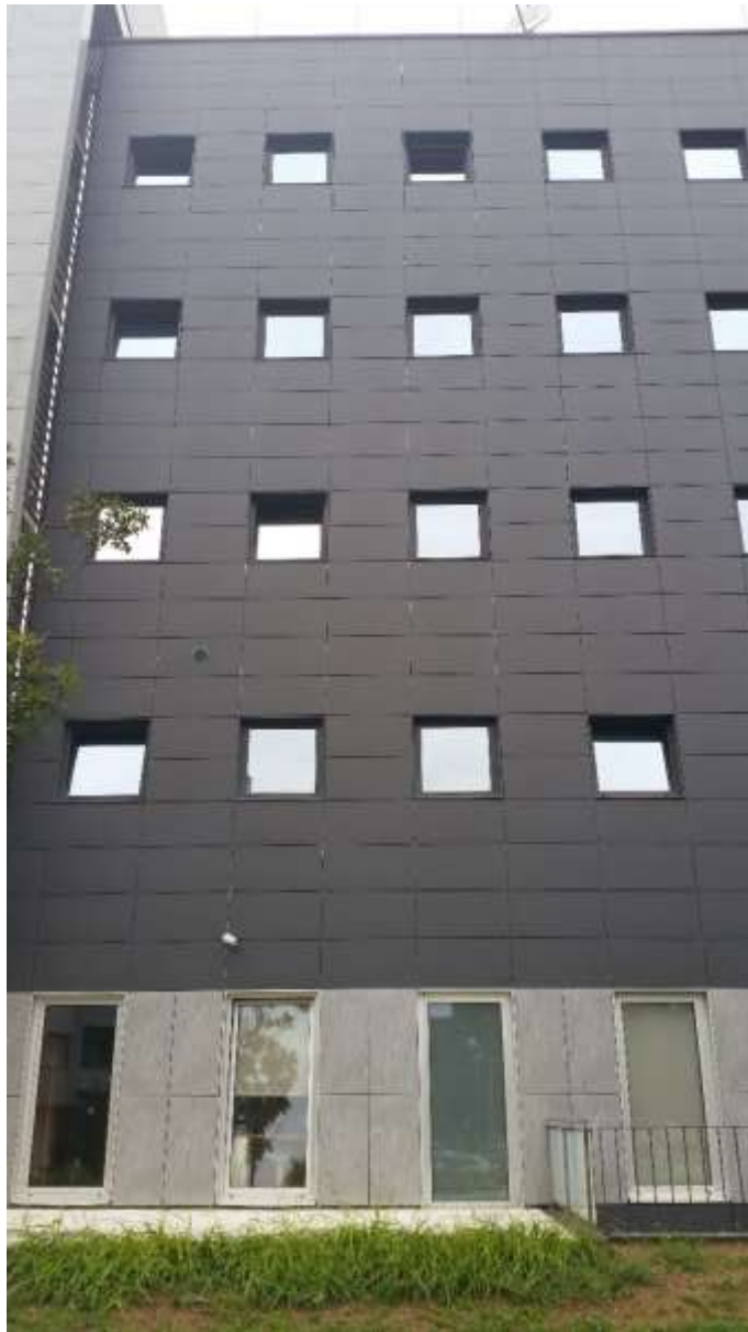
Slika 35. Ventilirajuća kamena fasada Zagrebačka banka Špansko, Zagreb
