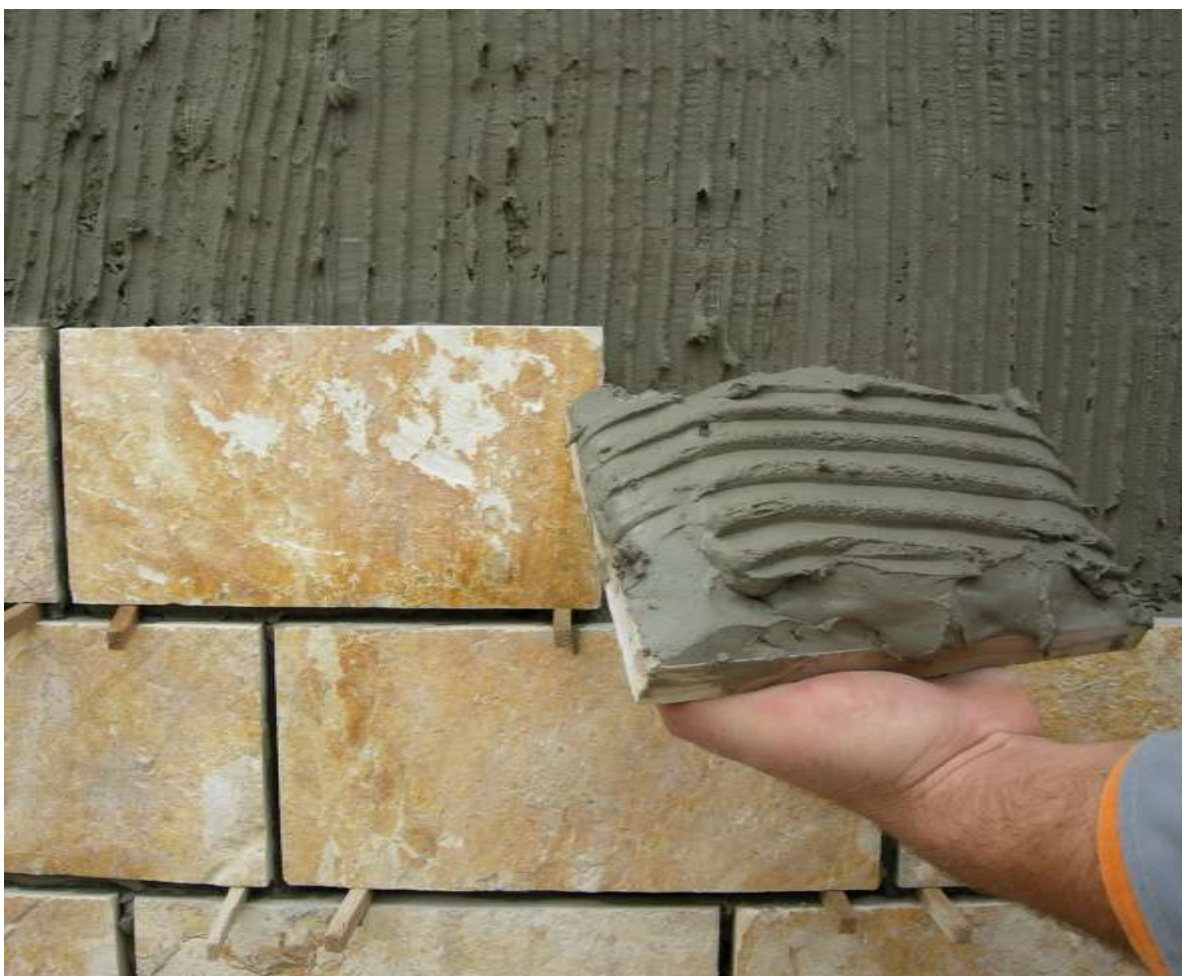
Slika 40. Oblaganje kamenim pločama
