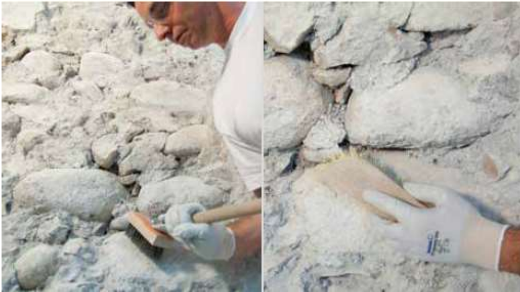
Slika 20. Ručno čišćenje kamenog zida četkom
