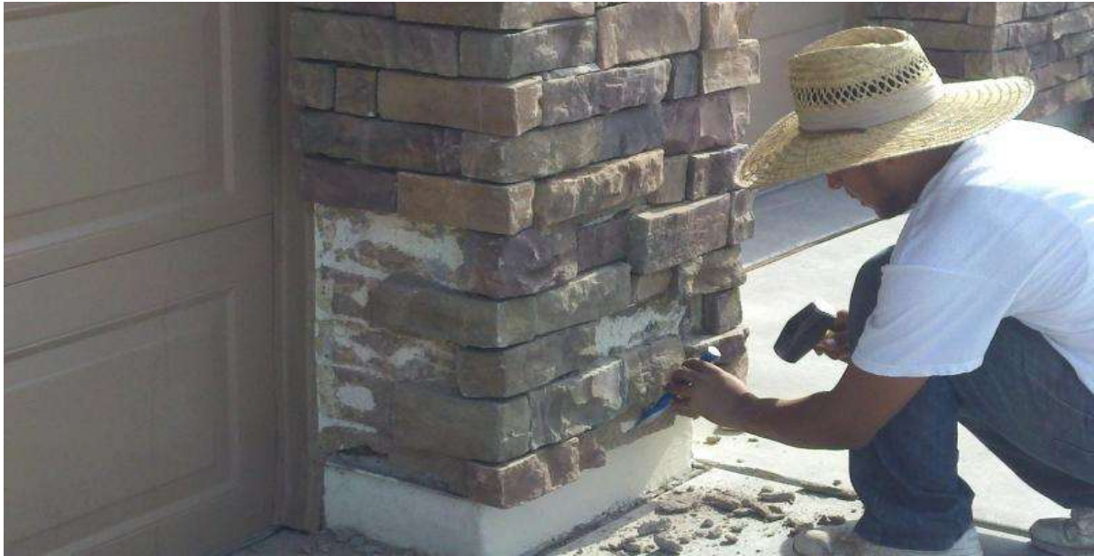
Slika 15. Skidanje labavih ploča i neodgovarajućeg veziva
