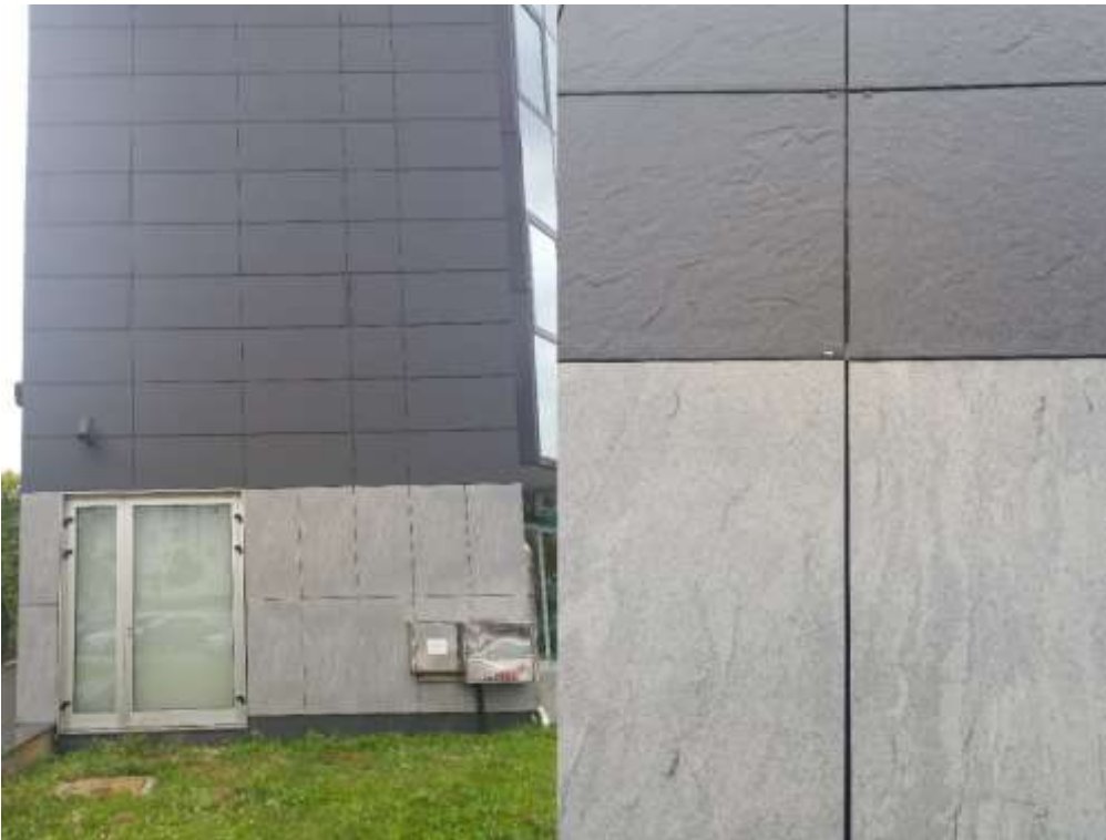
Slika 26. Ventilirajuća kamena fasada Zagrebačka banka Špansko, Zagreb
