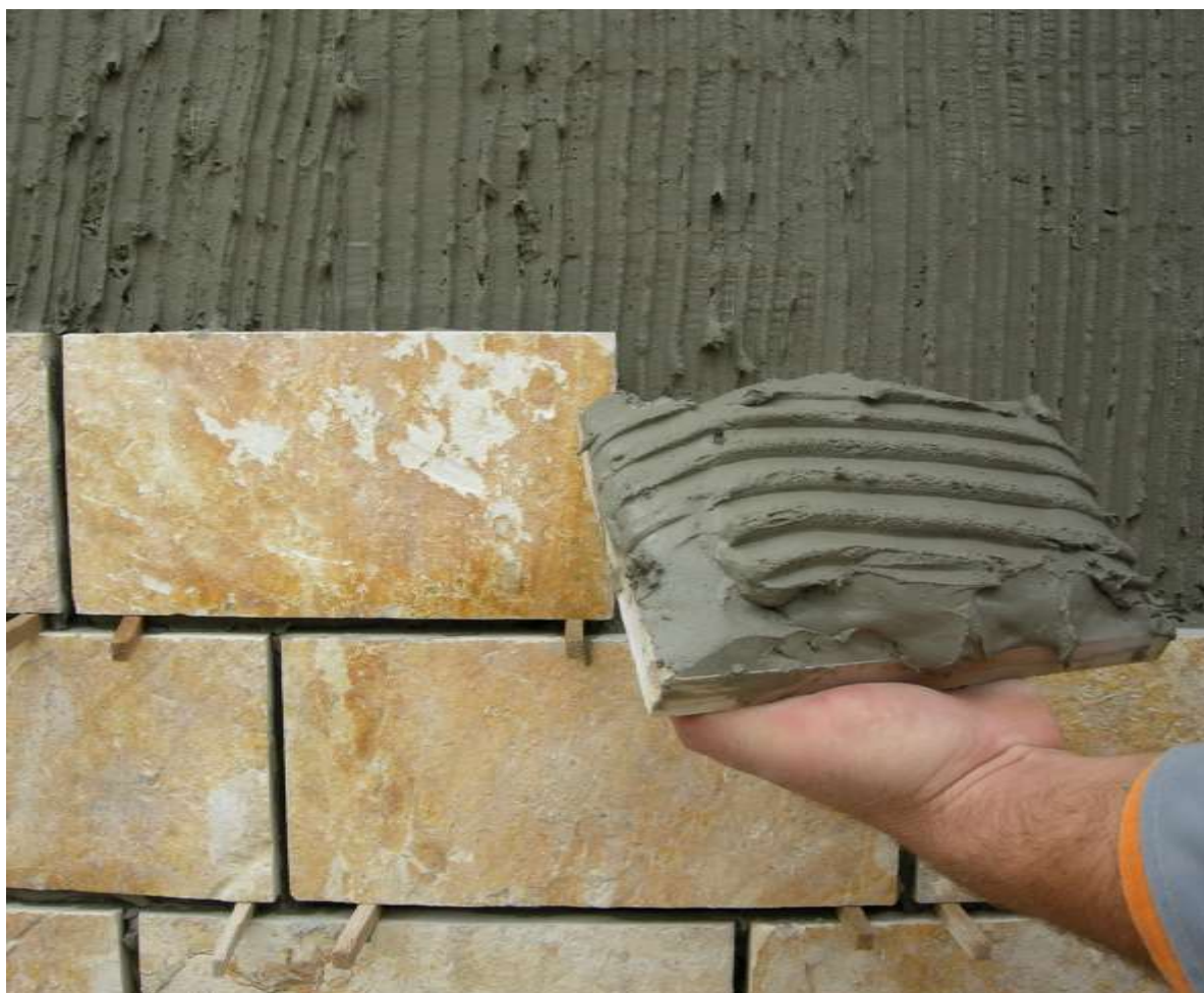
Slika 40. Oblaganje kamenim pločama
