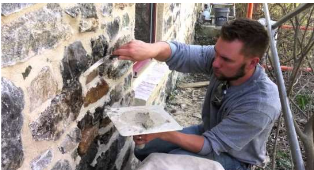
Slika 16. Zaglađivanje fuga sa žlicom
