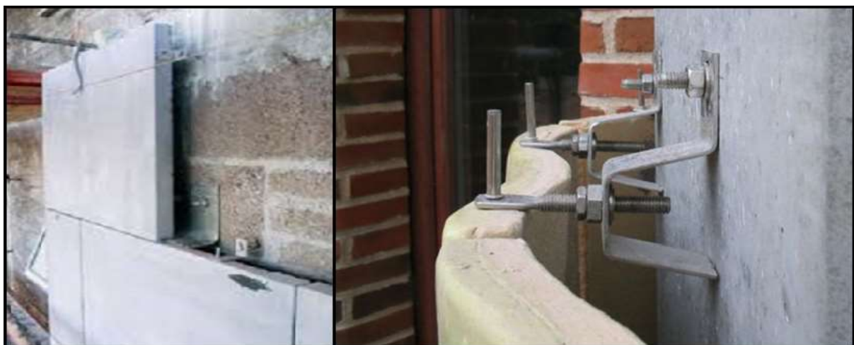
Slika 33. Postavljanje kamenih ploča na pročelje građevine
