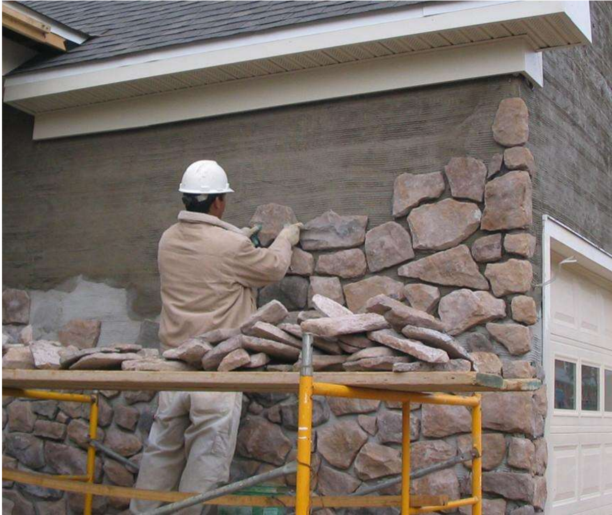
Slika 19. Postavljanje kamenih ploča na hrapavu površinu
