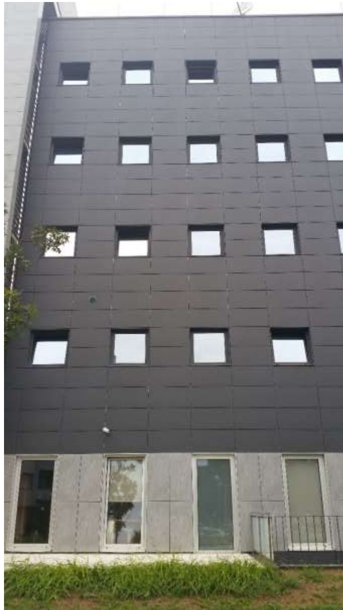
Slika 35. Ventilirajuća kamena fasada Zagrebačka banka Špansko, Zagreb
