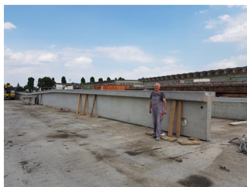
Slika 59. Skladištenje A nosača prije otpreme na montažu
