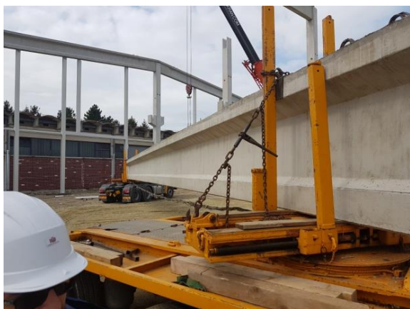
Slika 83. Doprema prefabriciranog krovnog nosača na kamionu
