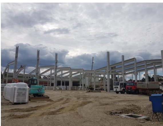
Slika 100 Trenutno stanje gradilišta
