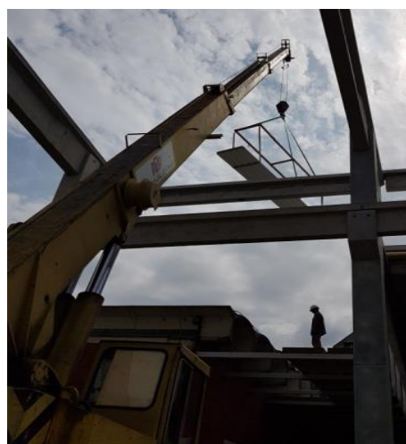
Slika 86. Montiranje pokrovnih panela
