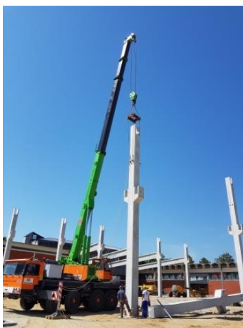
Slika 74. Postavljanje AB stupa u temeljnu čašu
