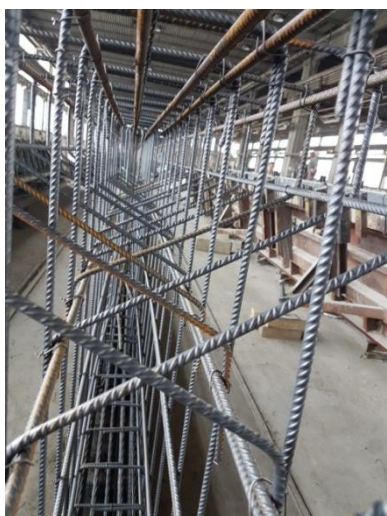
Slika 56. Armatura nosača
