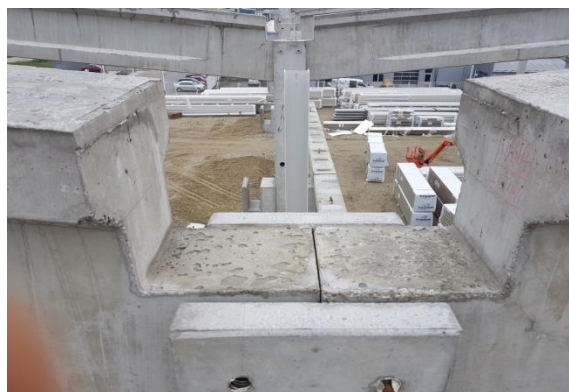
Slika 98 Montirani glavni nosači na vrhu stupa
