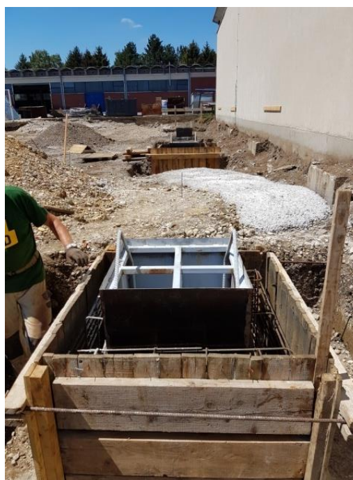
Slika 26. Postavljena oplata temeljne čašice stupa
