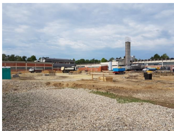
Slika 99 Gradilište na početku građenja
