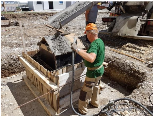
Slika 28. Vibriranje vibro iglom prilikom ugradnje betona
