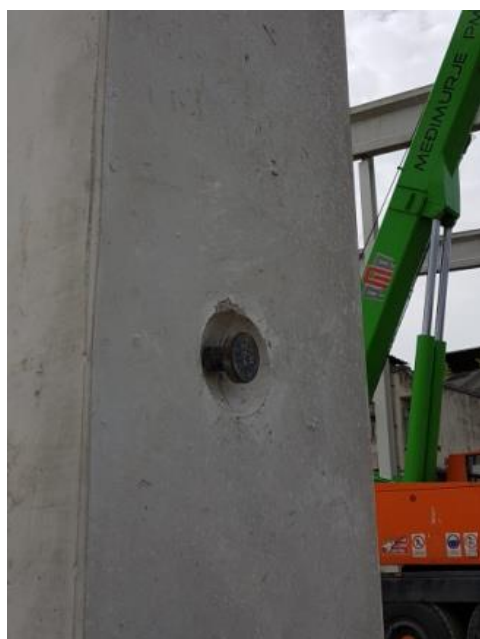
Slika 73. Prihvatnik na AB stupu koji se koristio kod utovara i istovara AB elemenata pomoću autodizalice
