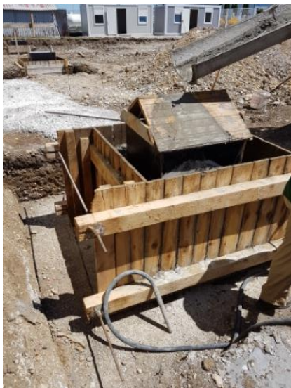
Slika 27. Početak betoniranja temeljne čašice
