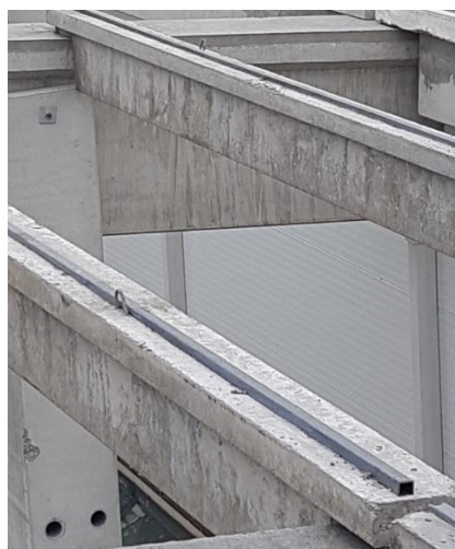
Slika 93. Montažne kuke na sekundarnom nosaču
