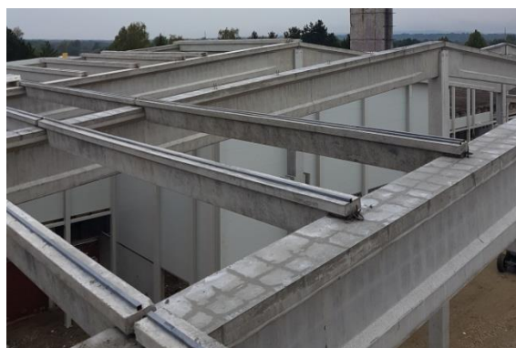
Slika 96 Montirani sekundarni nosači
