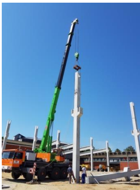
Slika 74. Postavljanje AB stupa u temeljnu čašu
