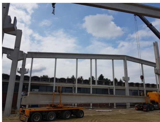
Slika 84. Priprema nosača za montiranje
