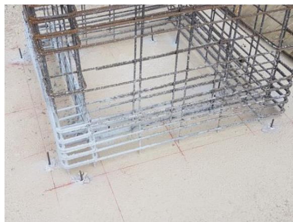
Slika 22. Iscrtane linije za postavu opate temeljne čašice stupa
