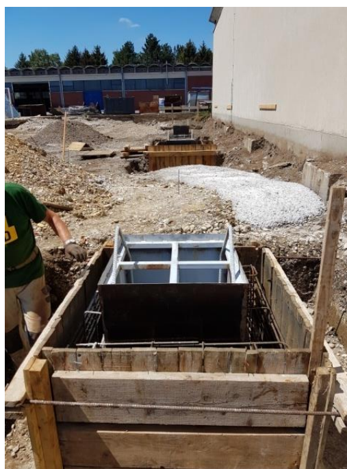
Slika 26. Postavljena oplata temeljne čašice stupa
