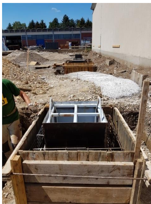
Slika 26. Postavljena oplata temeljne čašice stupa
