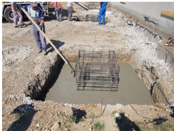
Slika 20. Poravnavanje betona nakon betoniranja
