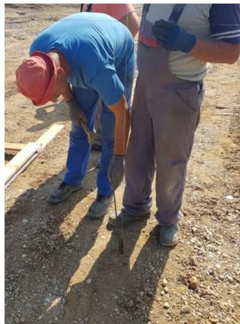
Slika 12. Viskovanje prije iscrtavanja temeljne stope
