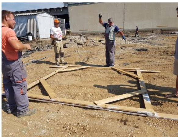
Slika 10. Iscrtavanje temeljne stope za potrebe strojnog iskopa
