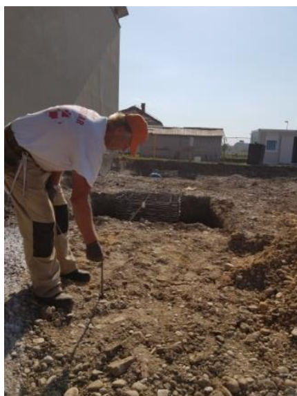
Slika 17. Centriranje armature temeljne čašice stupa pomoću pomoćnih oznaka stupa
