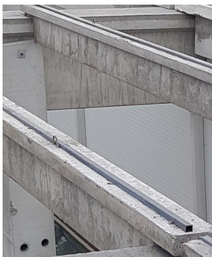
Slika 93. Montažne kuke na sekundarnom nosaču
