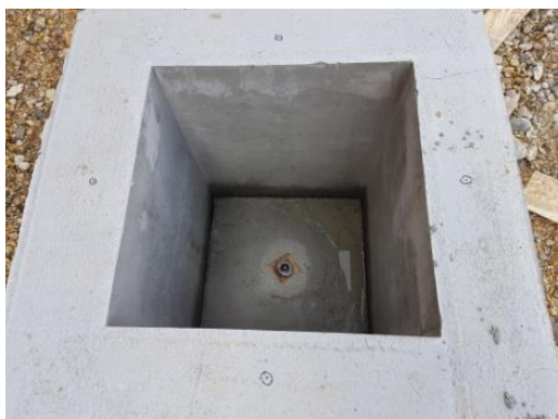
Slika 71. Prikaz postavljene čašice u temeljnoj čaši
