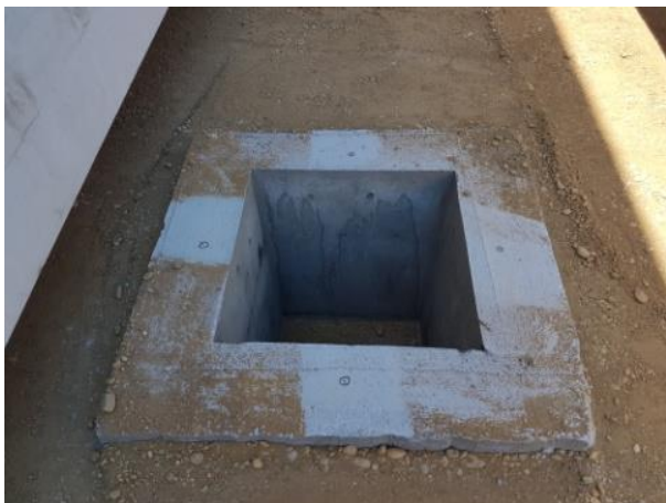
Slika 69. Geodetske oznake projektiranih osi stupova za potrebe postave metalnih temeljnih čašica, koje služe za montažu AB stupova
