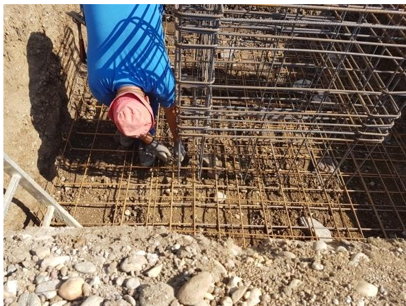
Slika 15. Postavljanje mrežaste armature za temelj temeljne i armature za temeljnu čašicu stupa
