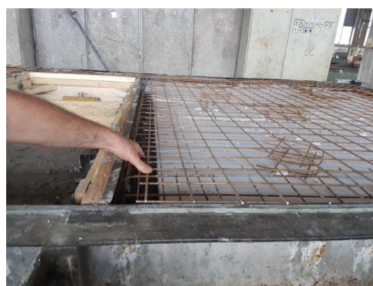
Slika 61. Armiranje AB fasadnog panela
