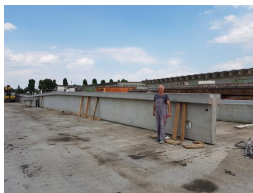
Slika 59. Skladištenje A nosača prije otpreme na montažu
