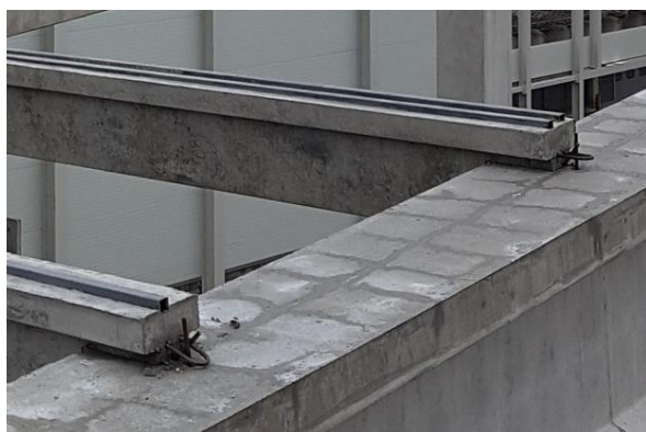
Slika 97 Vidljiv spoj sekundarnog nosača i klina
