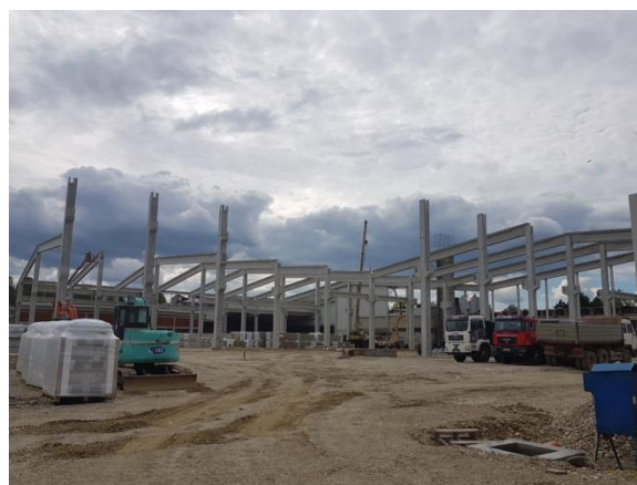
Slika 100 Trenutno stanje gradilišta
