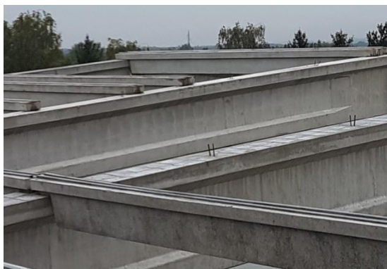
Slika 95 Montažni klinovi za sekundarne nosače
