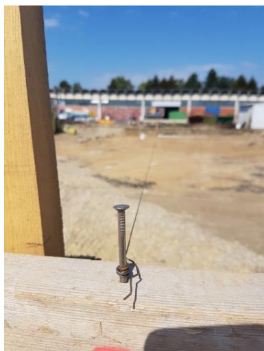
Slika 9. Pozicioniranje temeljnih stopa pomoću nanosne skele i paljene žice
