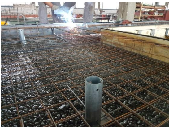
Slika 62. Proizvodnja AB fasadnog panela sa vidljivim kamenim granulatom
