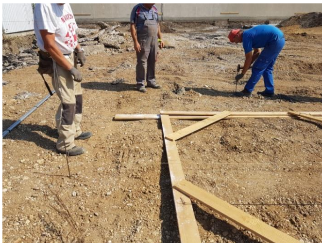
Slika 11. Označavanje pomoćnih oznaka za potrebe centriranja armature temeljnih čašica stupa
