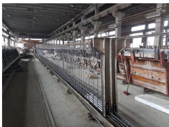
Slika 54. Armatura prednapregnutog nosača
