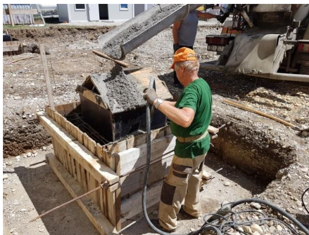
Slika 28. Vibriranje vibro iglom prilikom ugradnje betona
