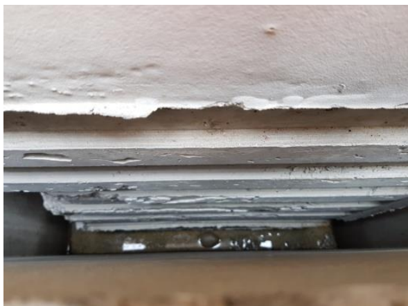
Slika 75. AB stup u temeljnoj čašici
