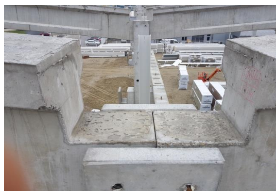
Slika 98 Montirani glavni nosači na vrhu stupa
