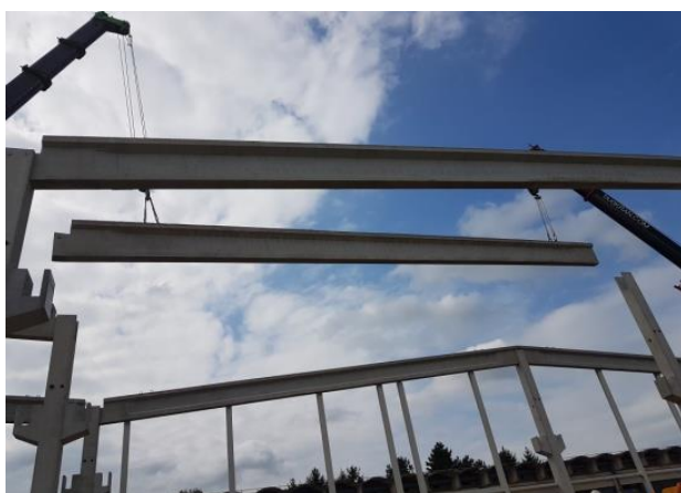
Slika 85. Montiranje prefabriciranog krovnog nosača
