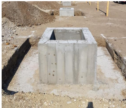
Slika 30. Prikaz gotove temeljne stope i temeljne čašice
