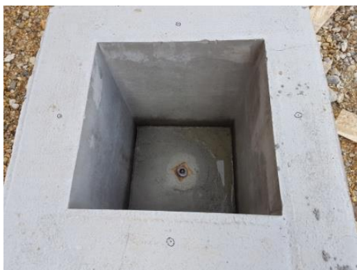
Slika 71. Prikaz postavljene čašice u temeljnoj čaši
