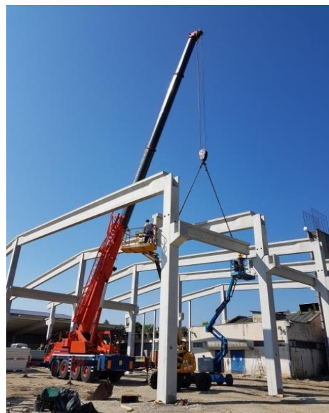
Slika 82. Montiranje AB kran
