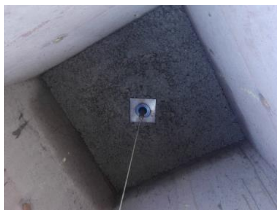
Slika 70. Postavljanje čašica u centar osi temeljnih ploča pomoću viska i geodetskih oznaka
