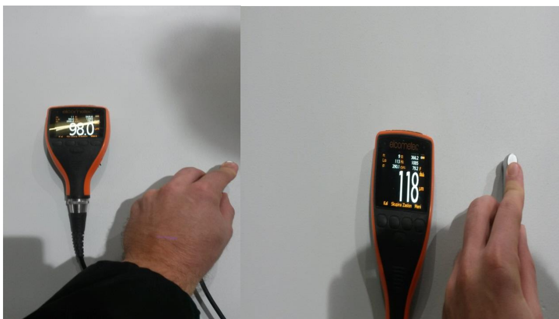
Slika 18. Mjerenje debljine suhog filma temeljnog sloja premaza
