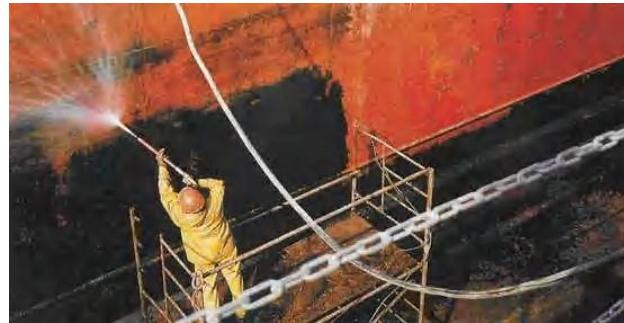
Slika 7. Vodeno pjeskarenje vanjske površine broda
